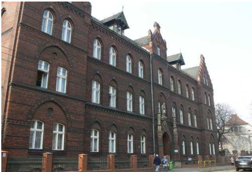
Budynek Zakładu św. Józefa – obecnie Specjalny Ośrodek Wychowawczy ul. Starokościelna 8
