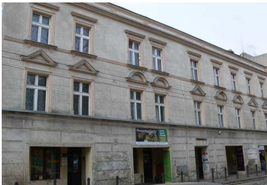
Budynek mieszkalno – usługowy ul. Starokościelna 4
