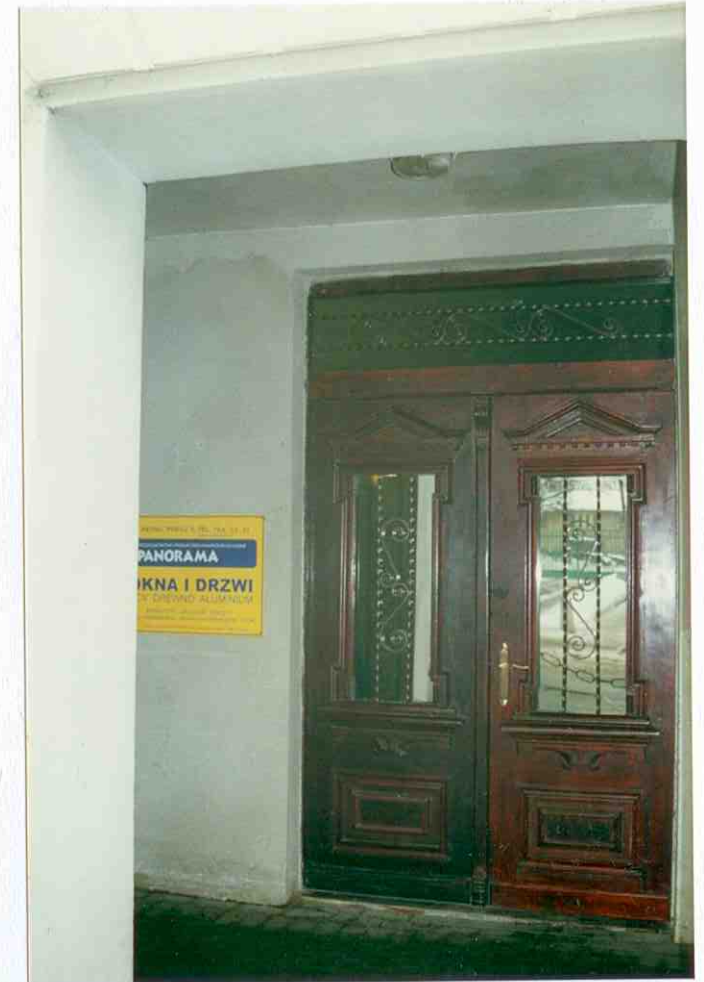
5. Stolarka drzwiowa. Elewacja wschodnia-frontowa.
