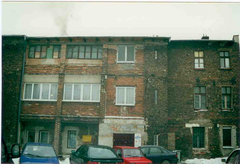
11. Fragment elewacji zachodniej - tylnej.
