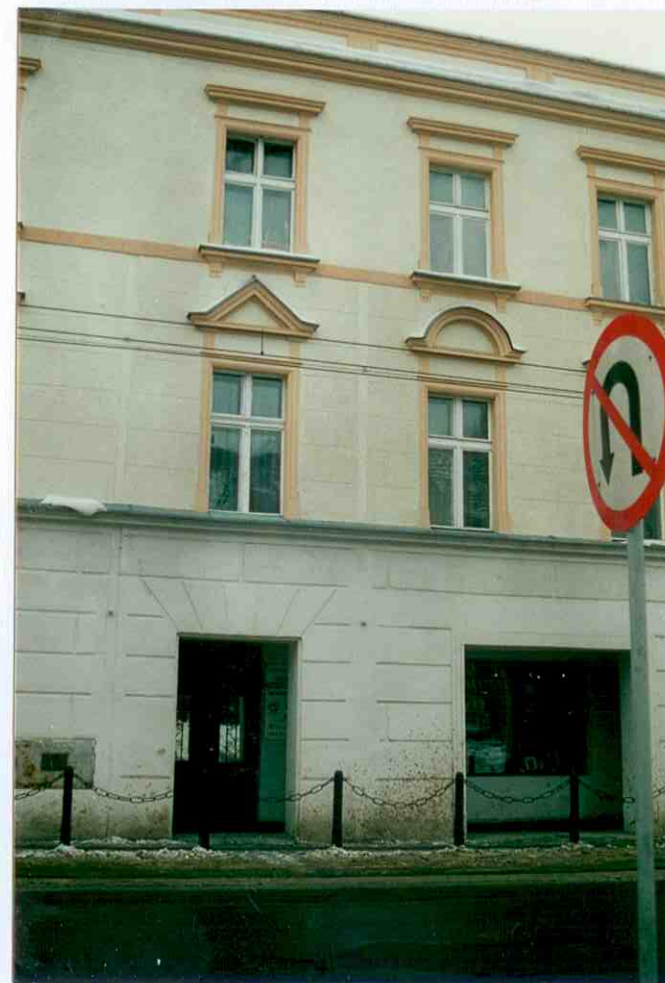
2. Fragment elewacji wschodniej - frontowej.
