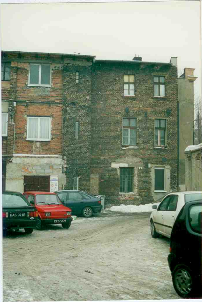
9. Fragment elewacji zachodniej-tylnej.
