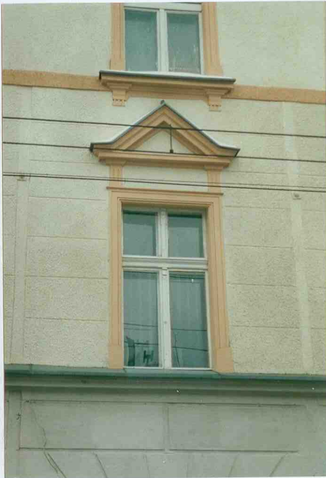
3. Okno. Elewacja wschodnia-frontowa.
