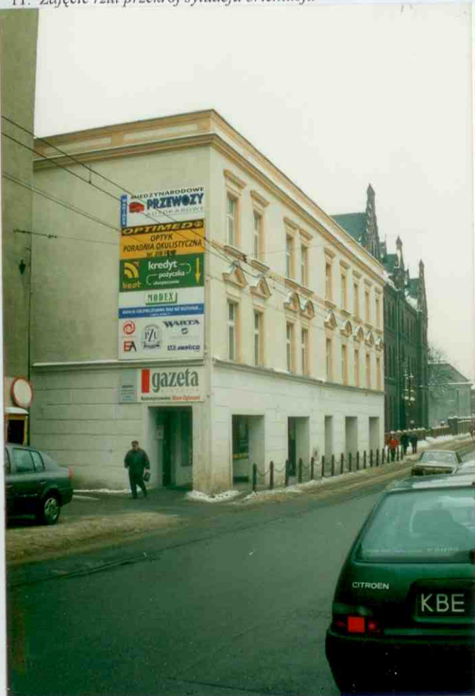
Widok ogólny od strony południowo-wschodniej.
