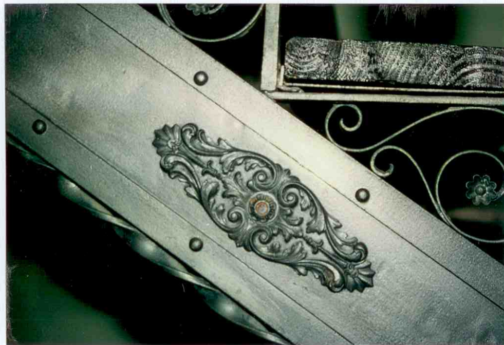
16. Detal. Klatka schodowa.
