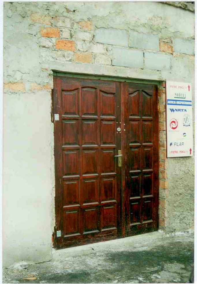
10. Stolarka drzwiowa. Elewacja zachodnia-tylna.
