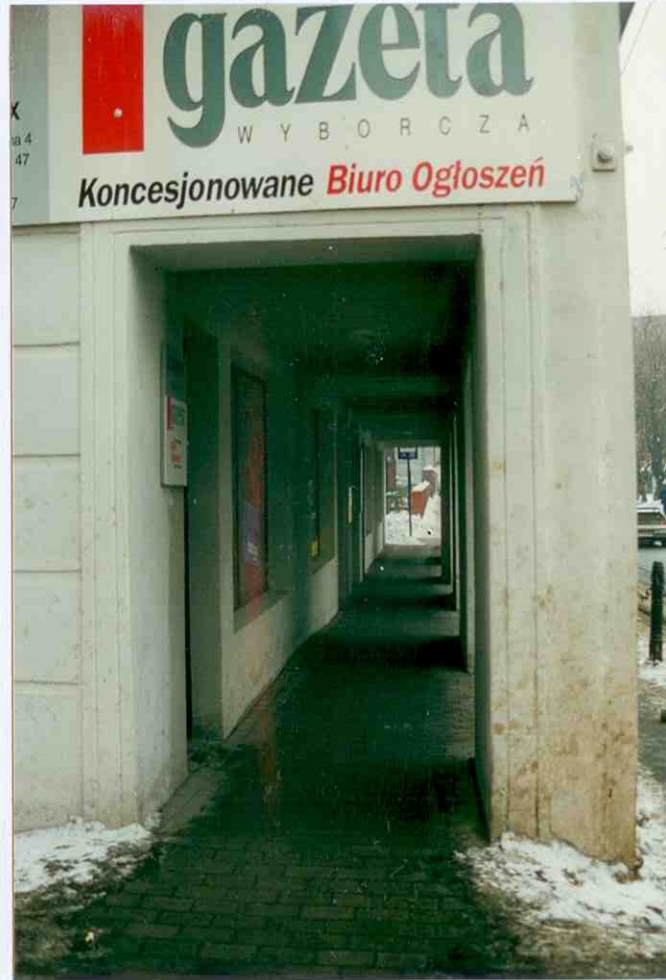
4. Podcienie. Elewacja wschodnia-frontowa.
