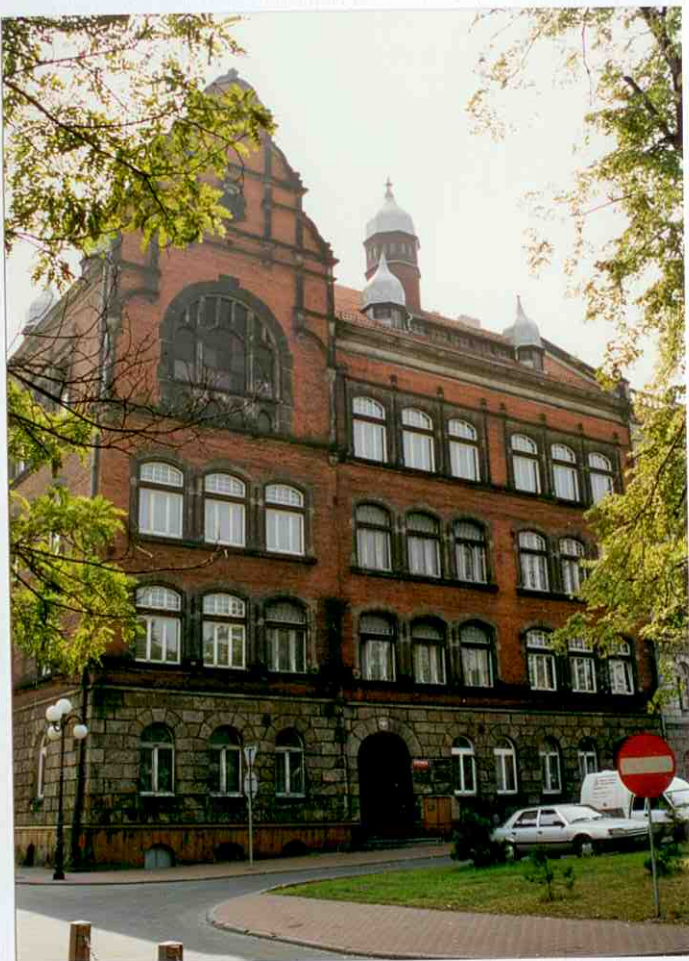
1 - Elewacja frontowa - widok ogólny
