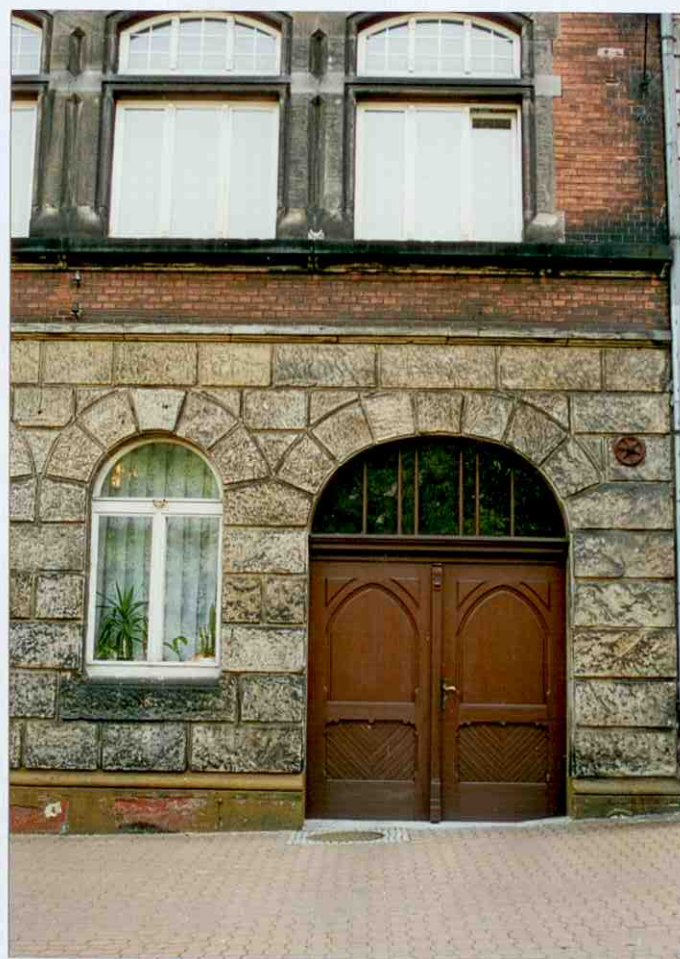
11 - Elewacja frontowa - sień przejazdowa
