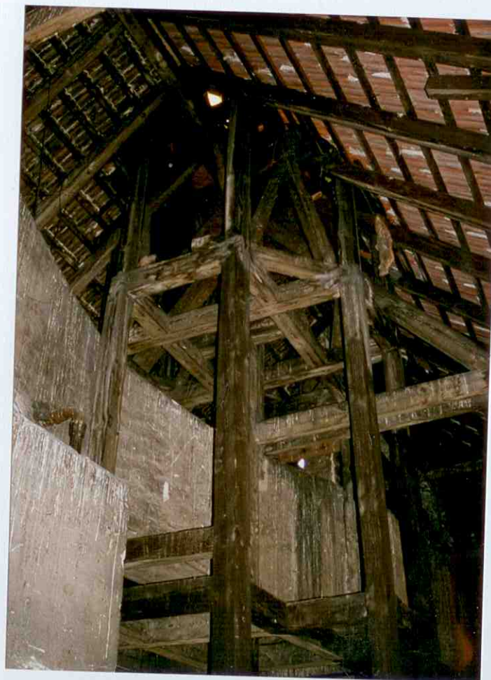
31 - Fragment więzby dachowej - konstrukcja wieżyczki
