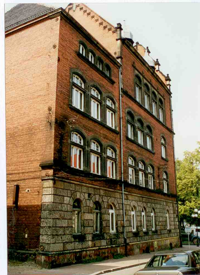
3 - Elewacja boczna północno-wschodnia widok ogólny
