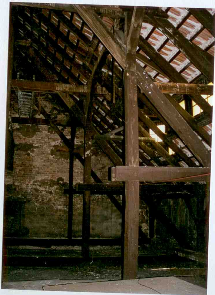
30 - Fragment więzby dachowej
