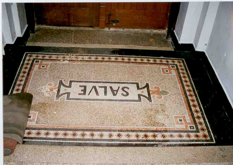
14 13 - Elewacja boczna północno-wschodnia - okna trzeciej i czwartej kondygnacji 14 - Przedsiónek - posadzka
