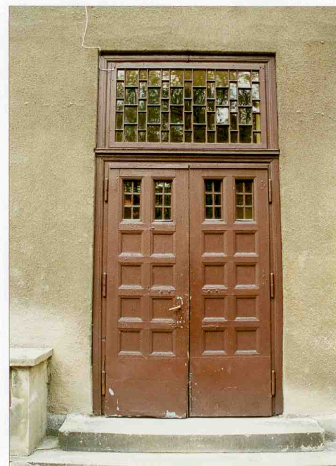
20 - Wyjście tylne - elewacja południowo-wschodnia
