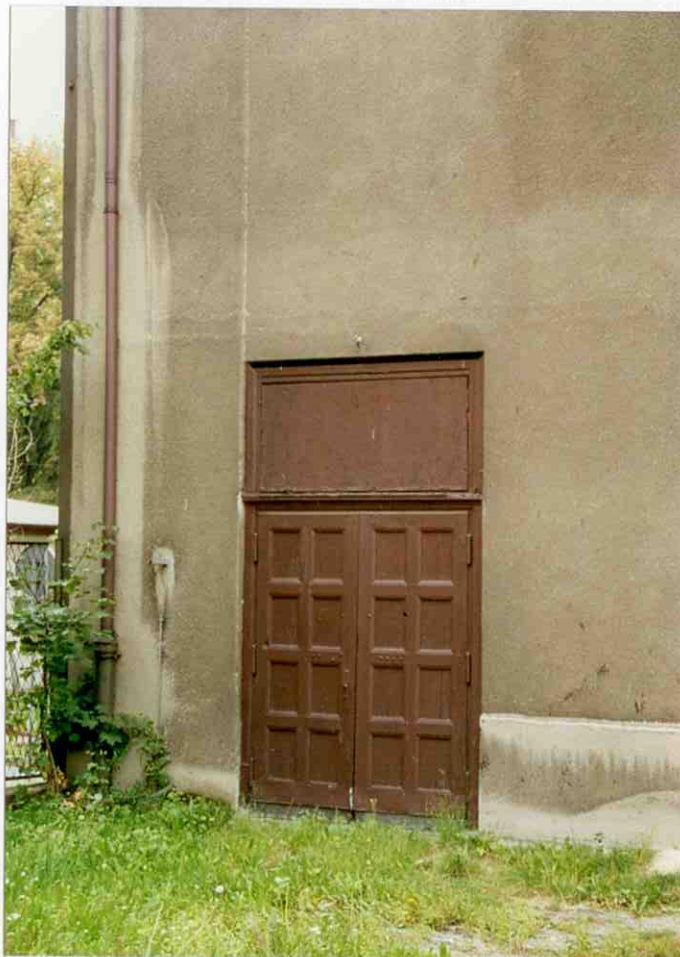
19 - Wyjście z sali gimnastycznej - elewacja tylna południowo-wschodnia
