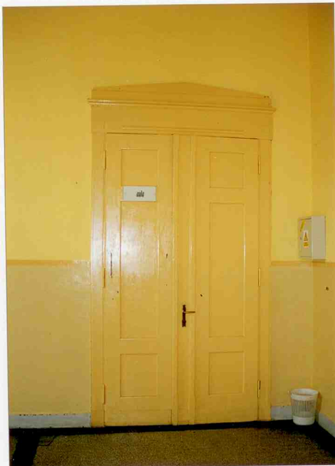
32 - Drzwi do auli - widok od strony korytarza
