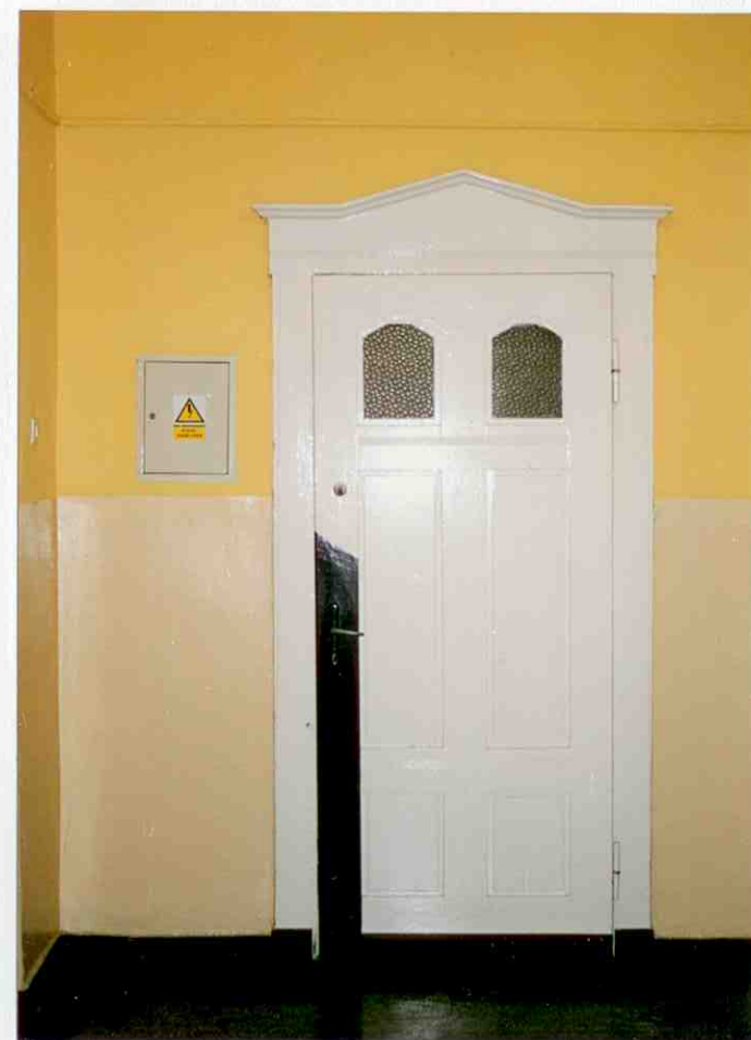
36 - Dawny internat - drzwi wewnętrzne - parter
