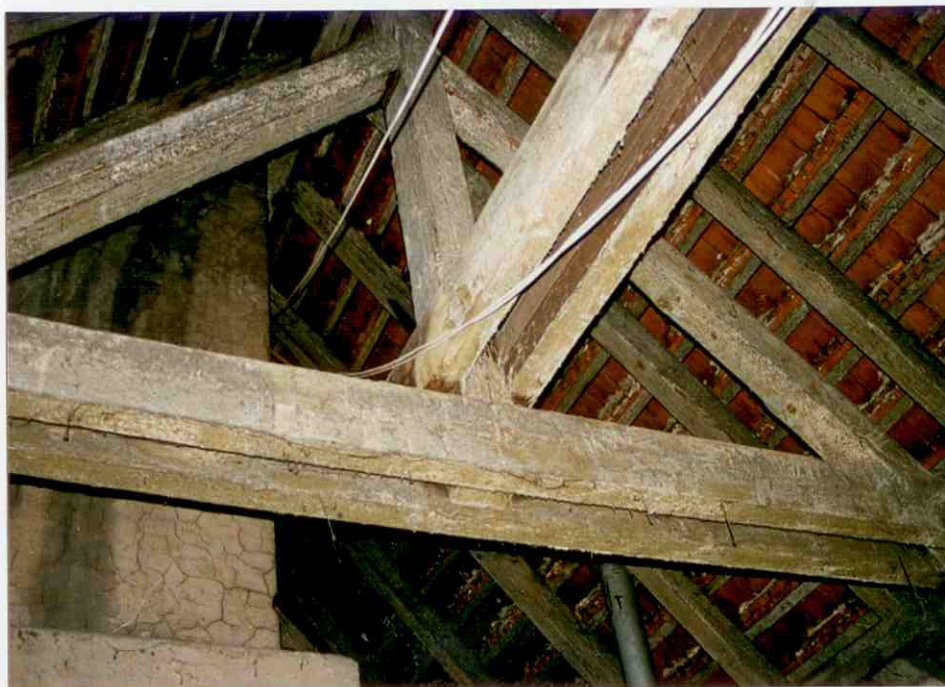
38 - Fragment więźby dachowej - skrzydło wschodnie
