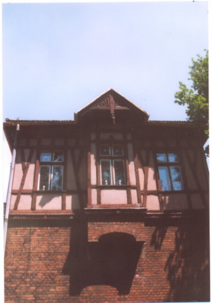
5. .Frag. elewacji zachodniej (frontowej). Wykusz.
