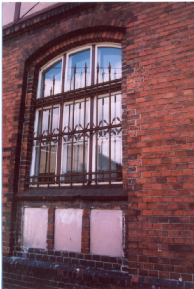
14. Elewacja północna. Okno.
