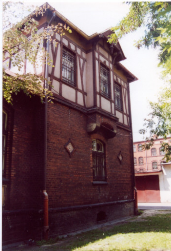
17. Frag. elewacji wschodniej.
