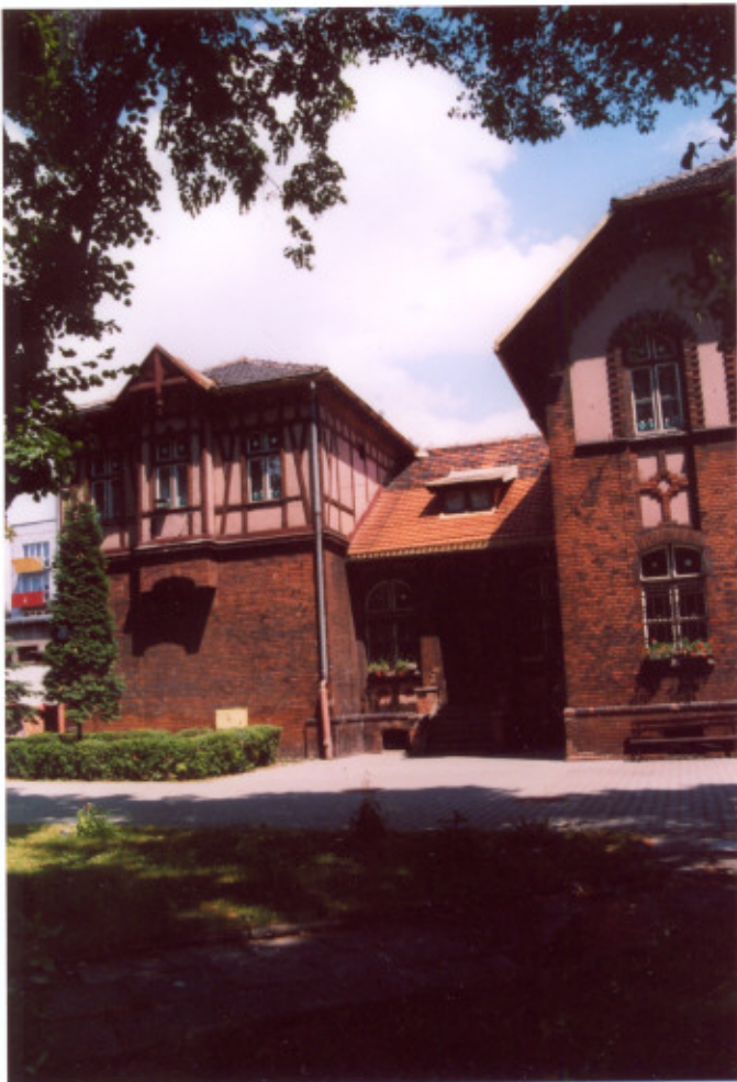
4. Frag. elewacji zachodniej (frontowej).
