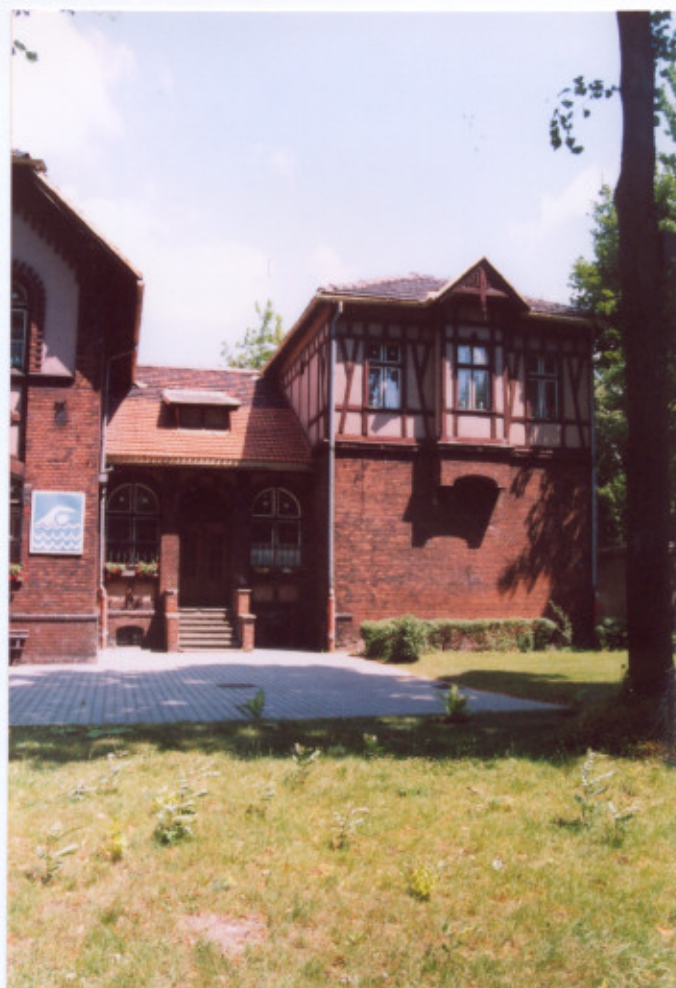
12. Frag. elewacji zachodniej (frontowej).
