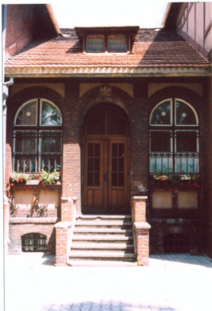
6. Frag. elewacji zachodniej (frontowej).
