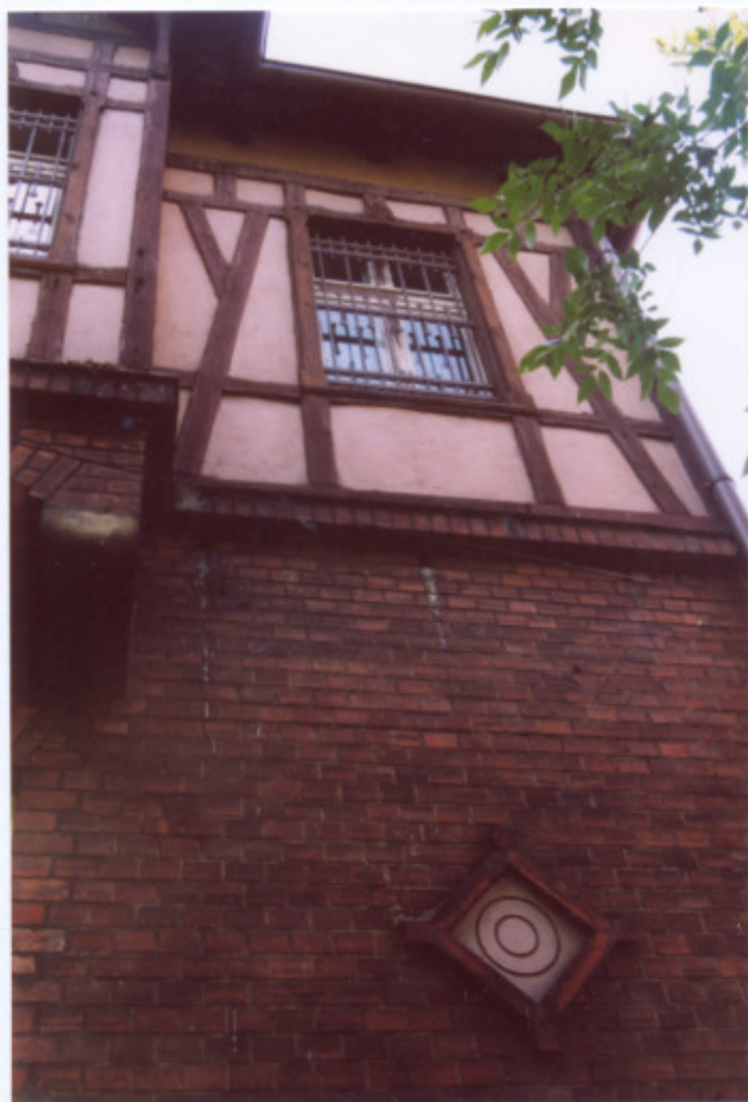
18. Frag. elewacji wschodniej.
