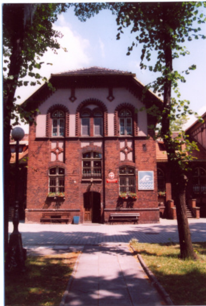
7. Frag. elewacji zachodniej (frontowej). Ryzalit.
