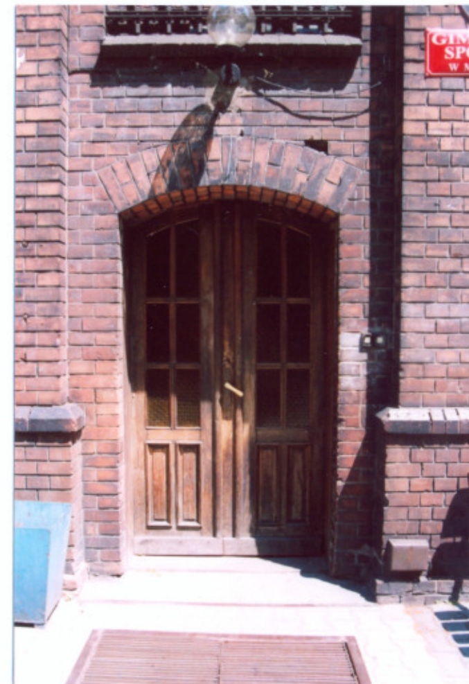
8. Frag. elewacji zachodniej (frontowej). Drzwi.
