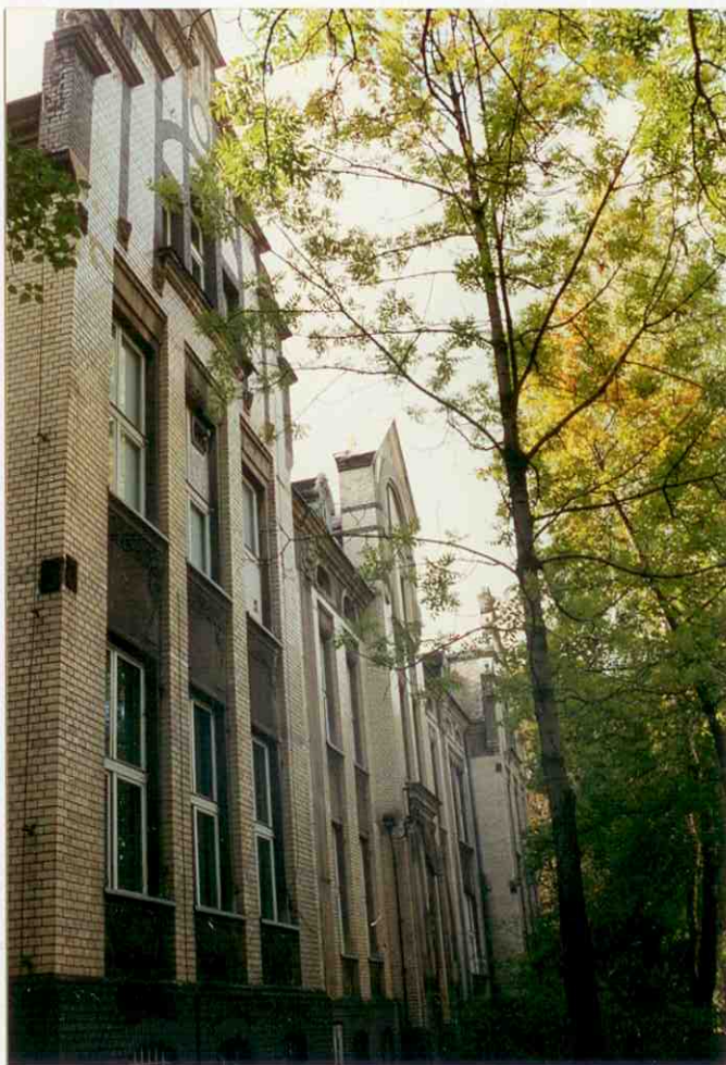
1. Elewacja północno-zachodnia (frontowa).
