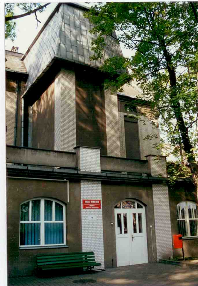
15. Fragment elewacji północno-wschodniej wraz z dobudówką szpitala.
