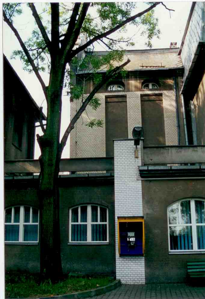
14. Fragment elewacji północno-wschodniej wraz z dobudówką szpitala.
