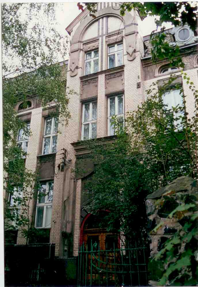
4. Ryzalit. Fragment elewacji północno-zachodniej (frontowej).
