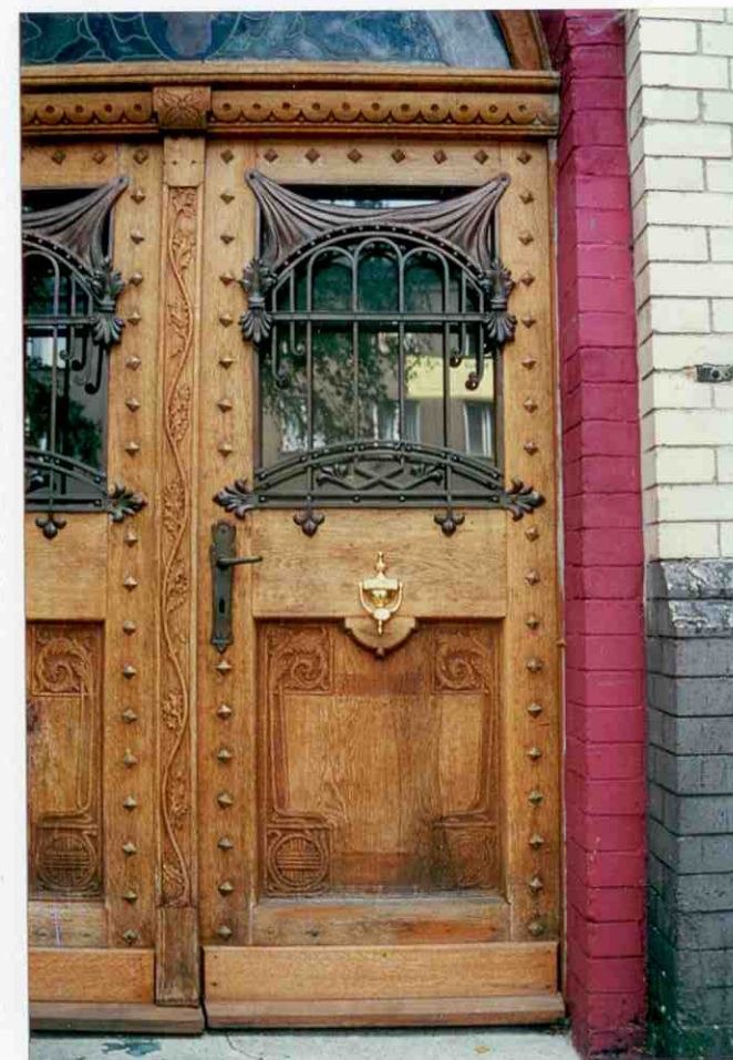
9. Drzwi. Fragment elewacji północno-zachodniej.
