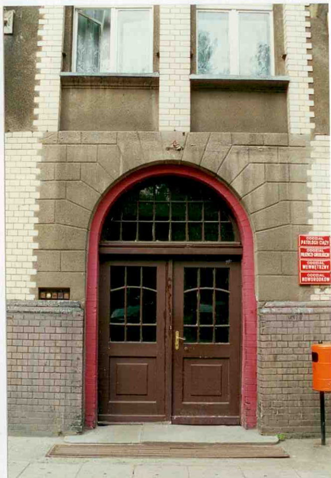
25. Drzwi. Fragment elewacji południowo-wschodniej. (tylna).
