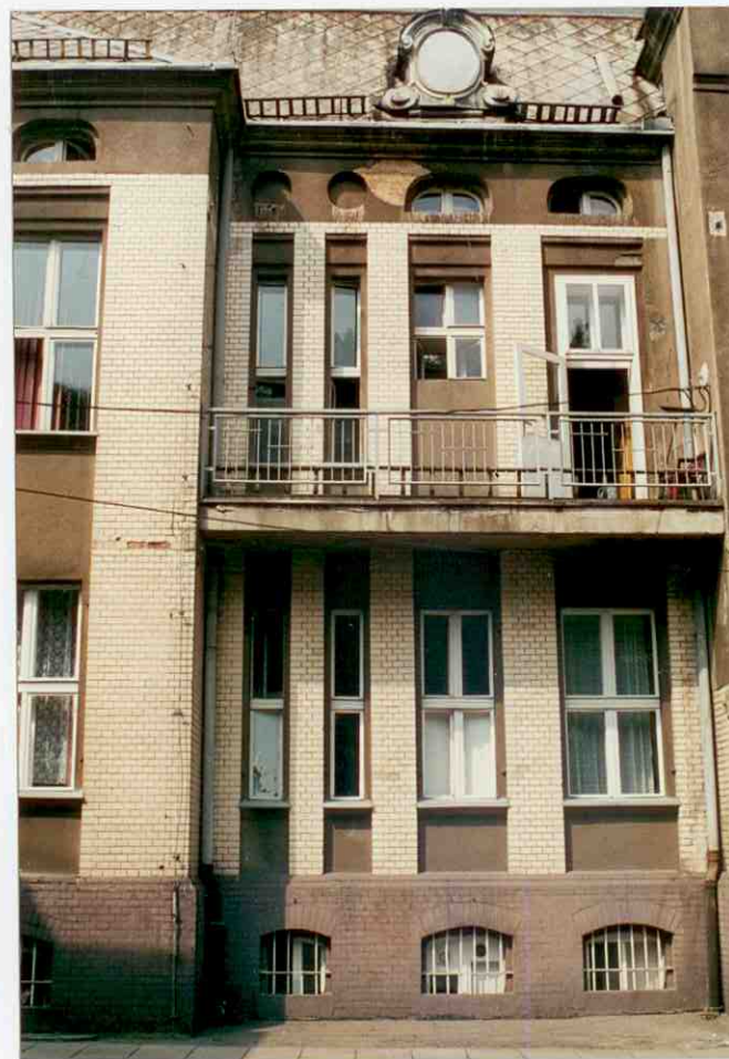
19. Fragment elewacji południowo-wschodniej (tylnej).
