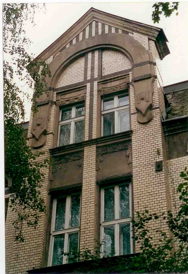
5. Ryzalit. Fragment elewacji północno-zachodniej (frontowej).
