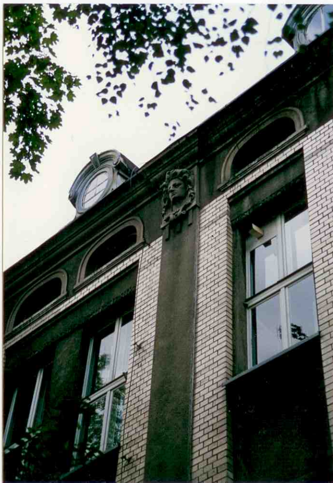
11. Fragment elewacji północno-zachodniej (frontowej).
