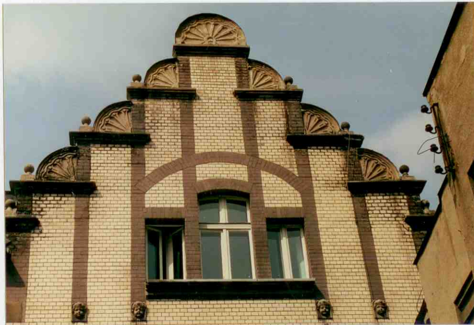
23. Szczyt. Fragment elewacji południowo-wschodniej.
