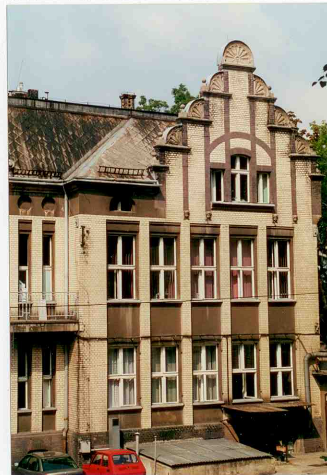
20. Fragment elewacji południowo-wschodniej (tylnej).
