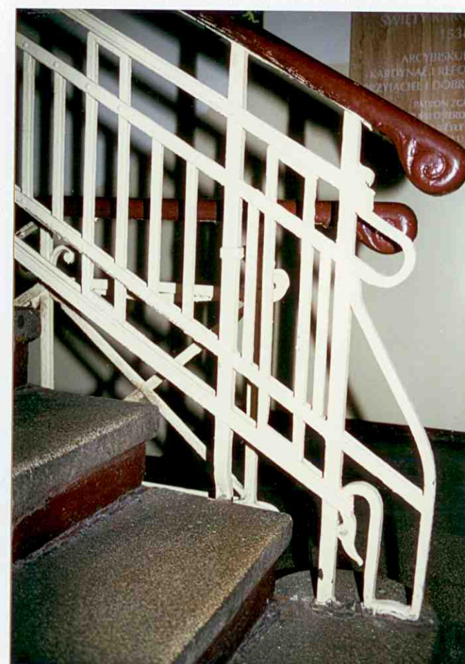
38. Bariera. Klatka schodowa.
