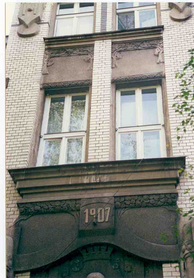
6. Ryzalit. Fragment elewacji północno-zachodniej (frontowej).
