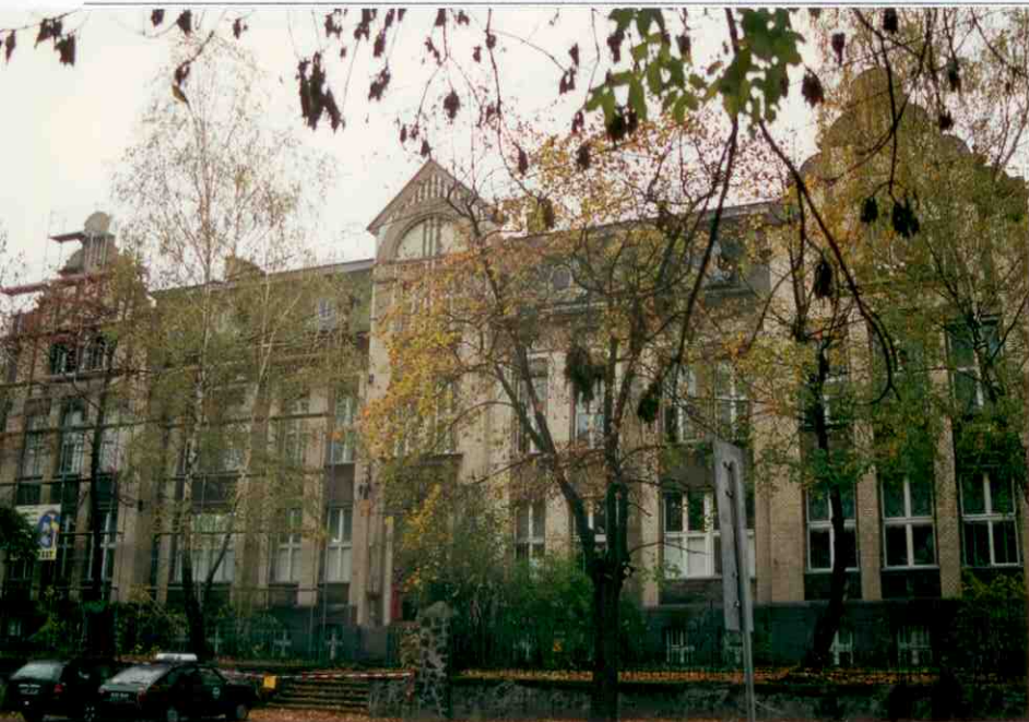
Elewacja północno-zachodnia (frontowa).
