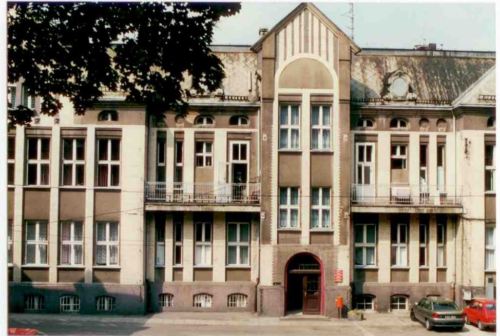
22. Fragment elewacji południowo-wschodniej.
