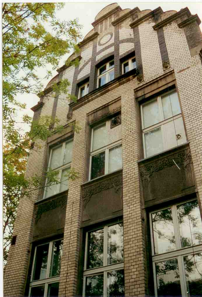
2. Fragment elewacji północno-zachodniej (frontowej).
