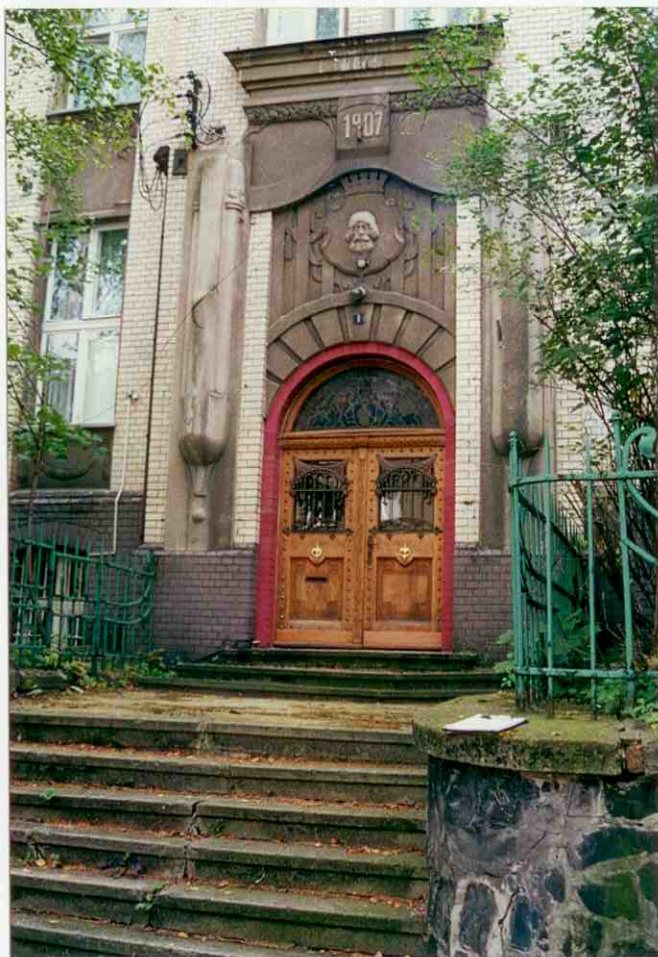
7. Portal. Fragment elewacji północno-zachodniej.
