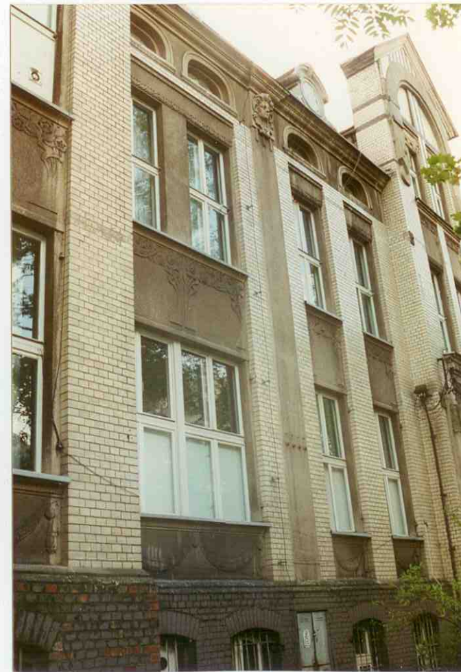
3. Fragment elewacji północno-zachodniej (frontowej).
