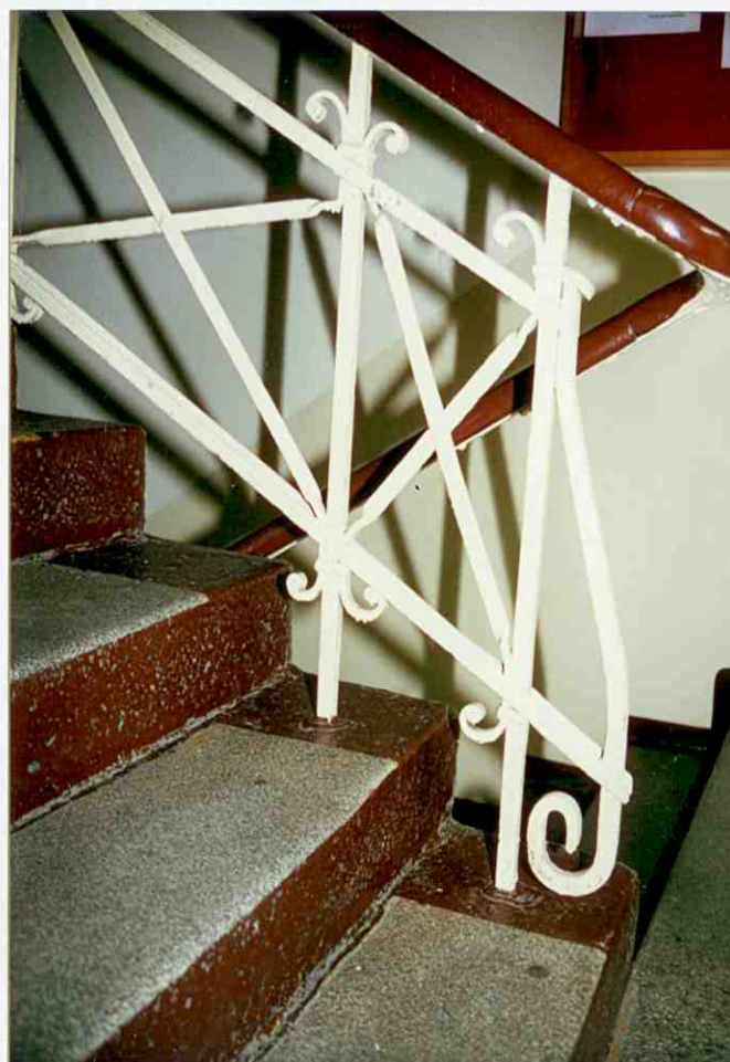
37. Bariera. Klatka schodowa.
