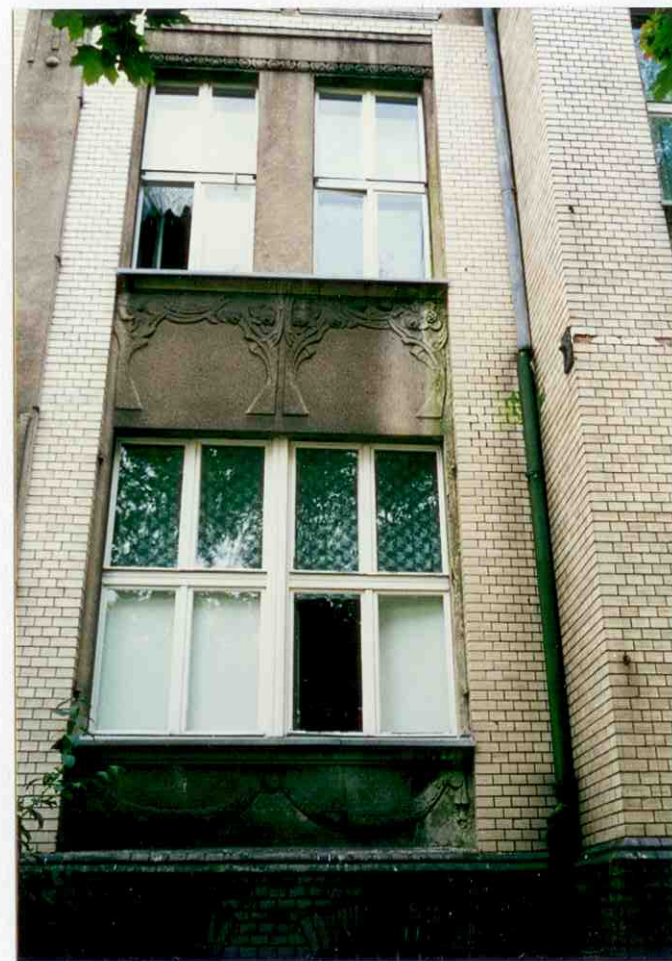
12. Fragment elewacji północno-zachodniej (frontowej).
