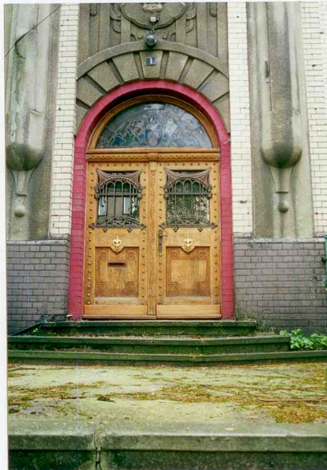
8. Drzwi. Fragment elewacji północno-zachodniej.
