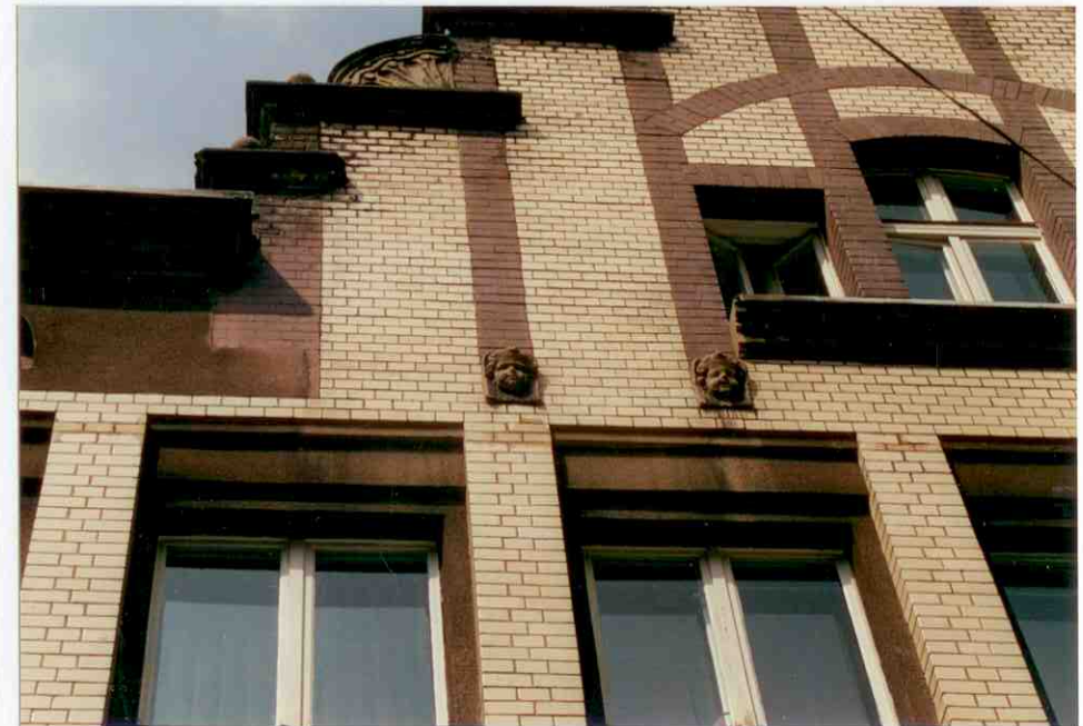
24. Szczyt. Fragment elewacji południowo-wschodniej.
