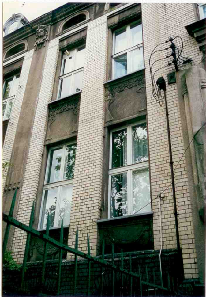
10. Fragment elewacji północno-zachodniej (frontowej).
