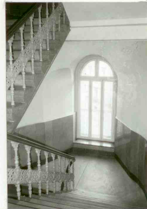
FRAGMENT KLATKI SCHODOWEJ
