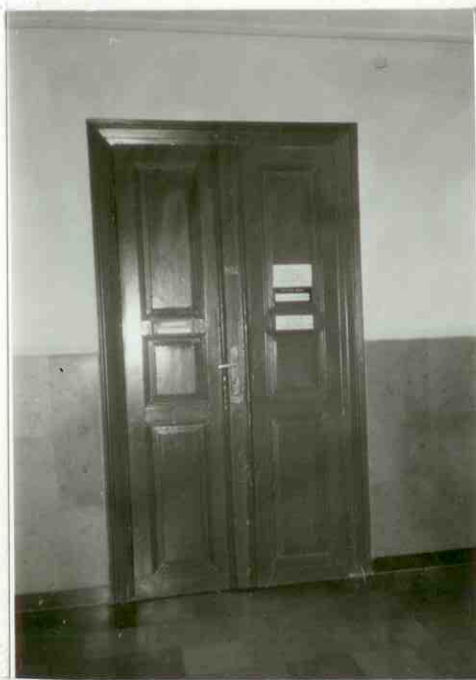
ZACHOWANA STOLARKA DRZWIOWA
