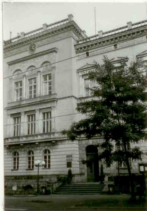
FRAGMENT ELEWACJI ZACHODNIEJ
