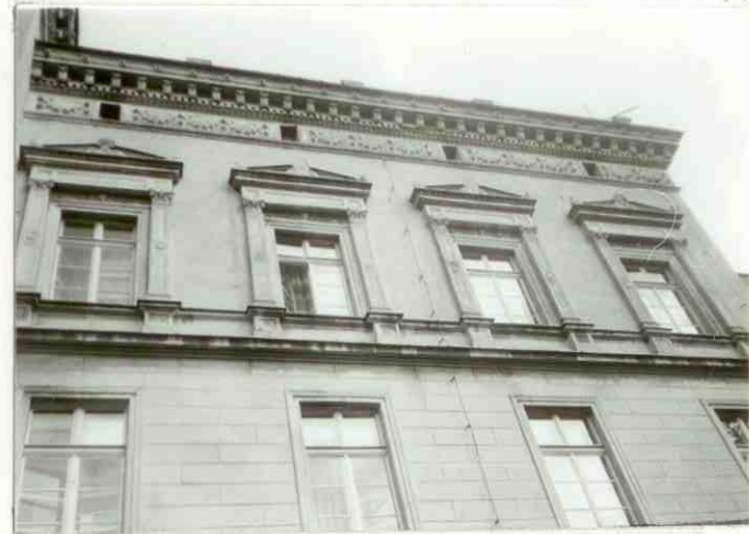
FRAGMENT ELEWACJI ZACHODNIEJ
