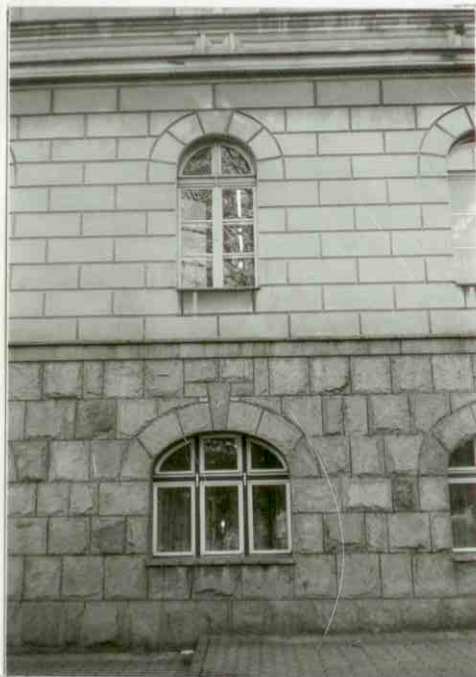
OKNA: PIWNICZNE I NA PARTERZE
