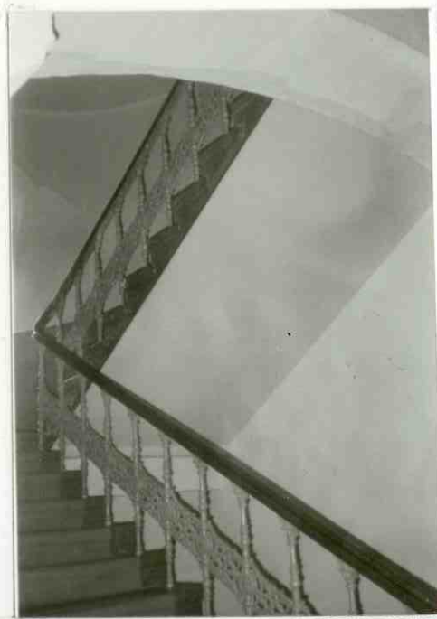
FRAGMENT KLATKI SCHODOWEJ
