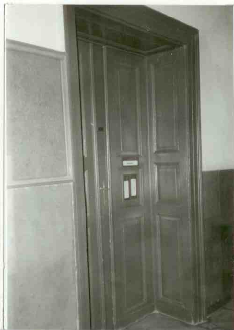
ZACHOWANA STOLARKA DRZWIOWA
