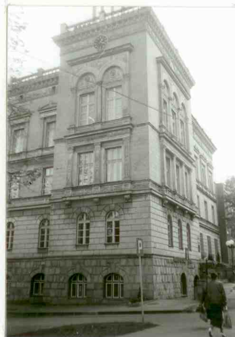
WIEŻA -NAROŻNIK PÓLNO-CNO-ZACHODNI
