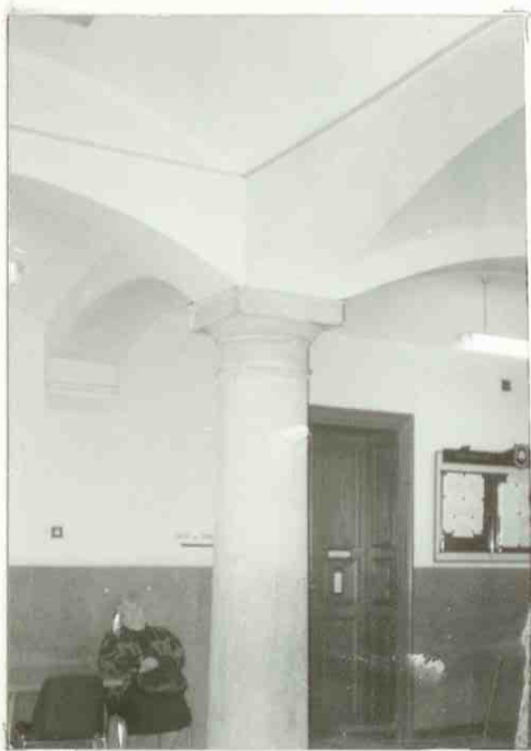
WNĘTRZE - KOLUMNA PODTRZYMUJĄCA SKLEPIENIE
