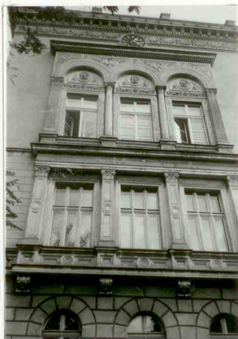
FRAGMENT ELEWACJI ZACHODNIEJ- GÓRNA CZĘŚĆ WIEŻY
