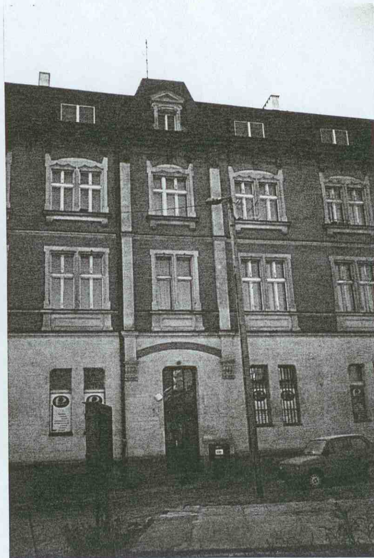
WEJŚCIE DO BUDYNKU
