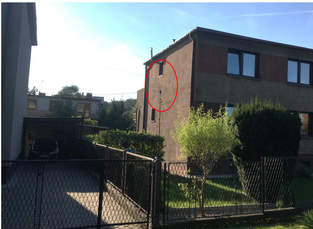
Fot. 4-5 Widok na punkt pomiarowy P2.
