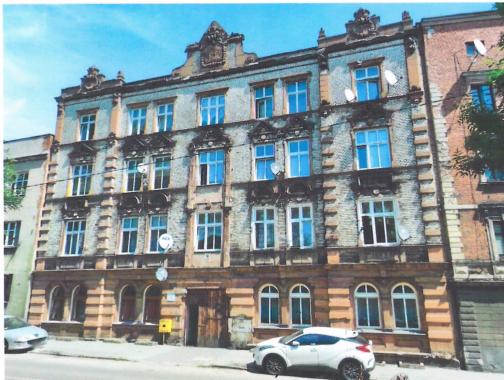
Widok budynku od południowego-zachodu
