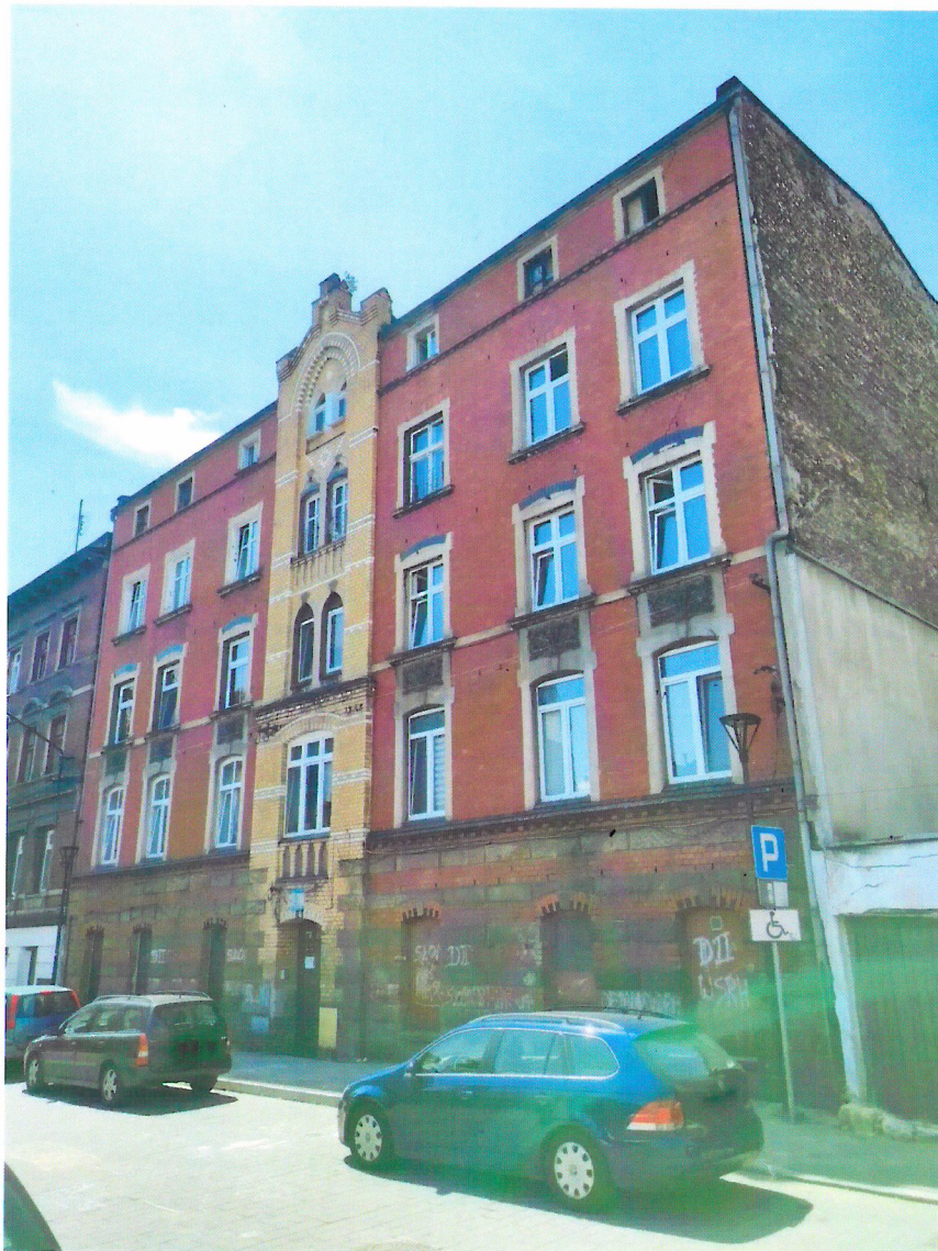
Widok budynku od północnego-wschodu
