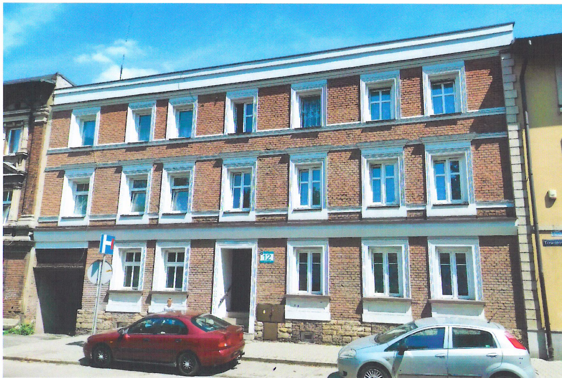
Widok budynku od południowego-zachodu
