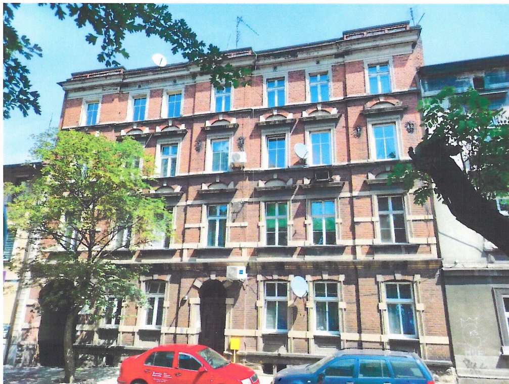
Widok budynku od południowego-zachodu
