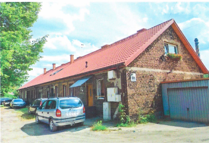
Widok budynku nr 60 od północnego-zachodu
