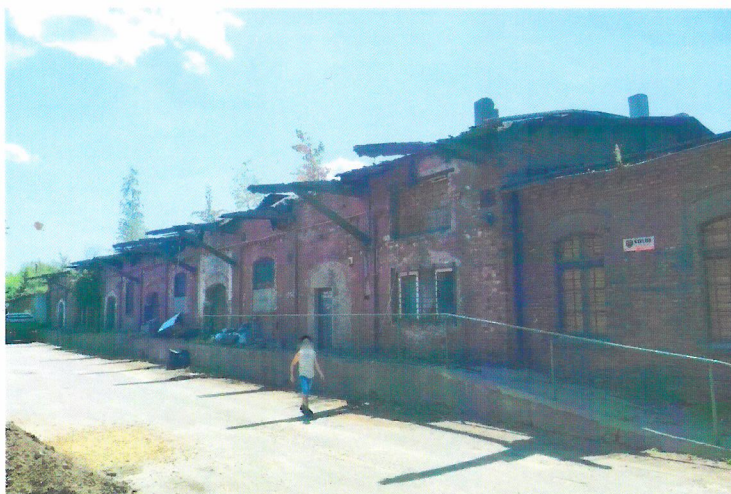
Widok budynku od północy
