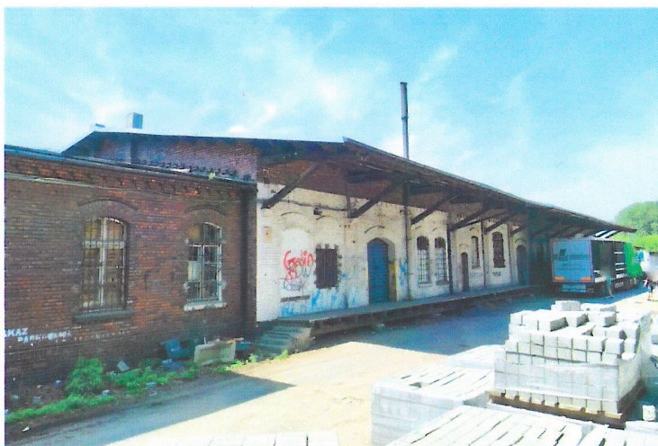
Widok budynku od wschodu
