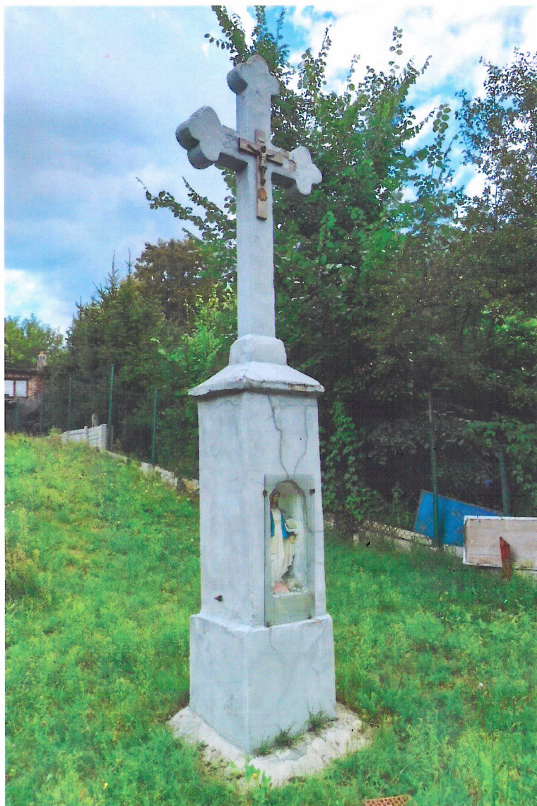
Widok od południowego-wschodu
