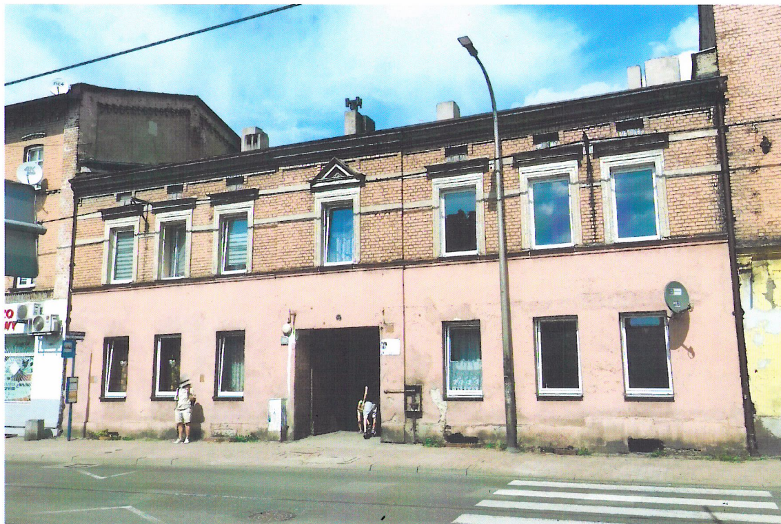
Widok budynku od południowego-zachodu
