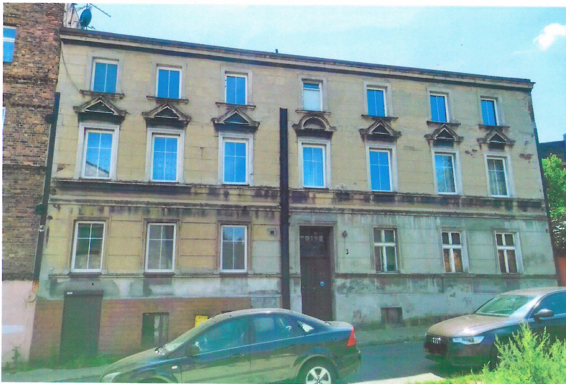
Widok budynku od północnego-zachodu
