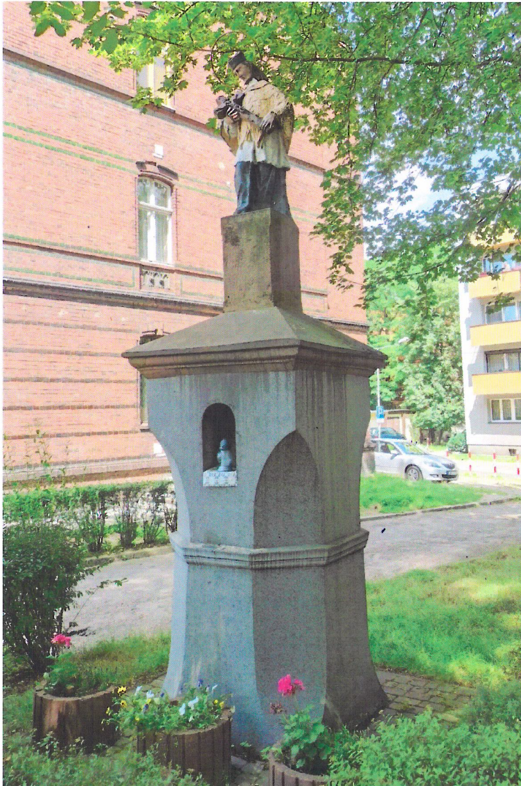
Widok od południowego-zachodu
