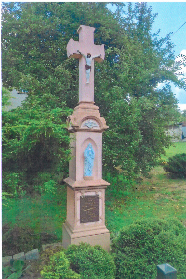
Widok od północnego-zachodu
