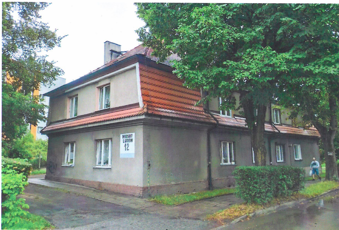
Widok budynku od północnego-zachodu
