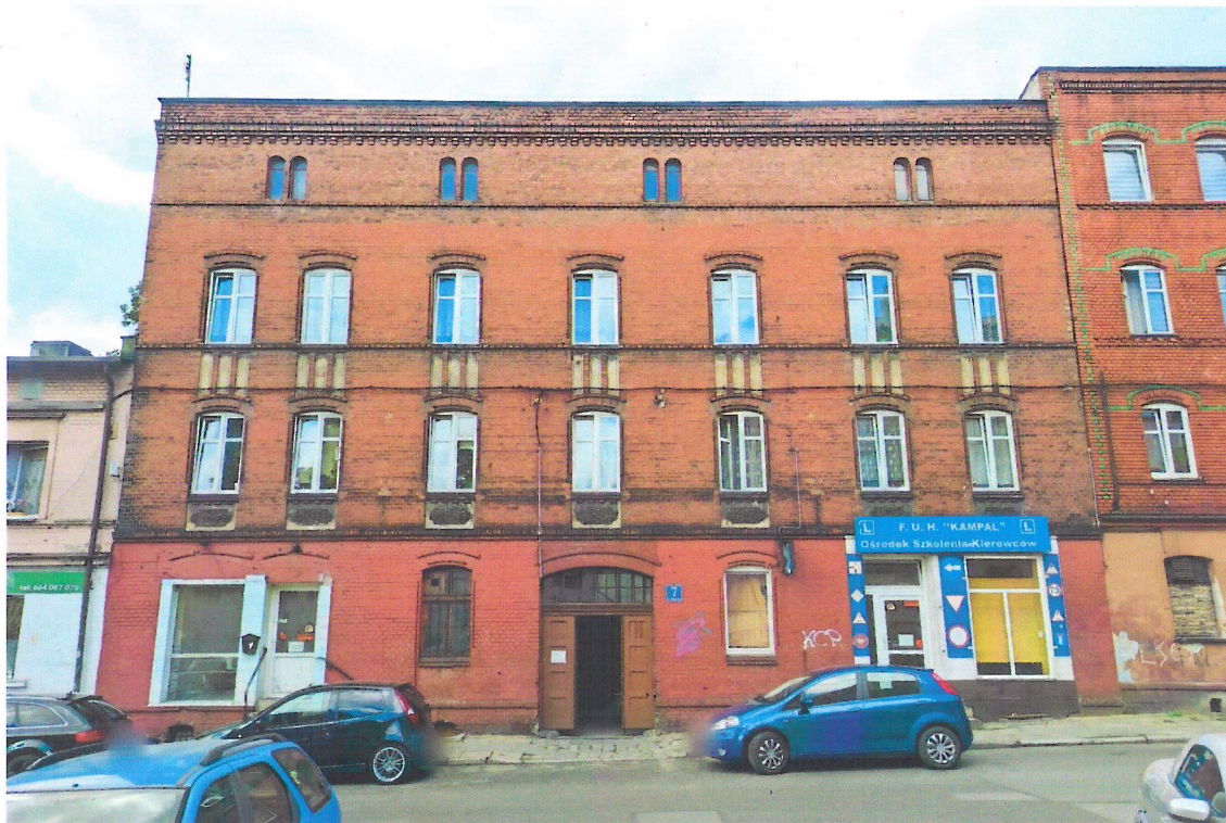
Widok budynku od północnego-wschodu
