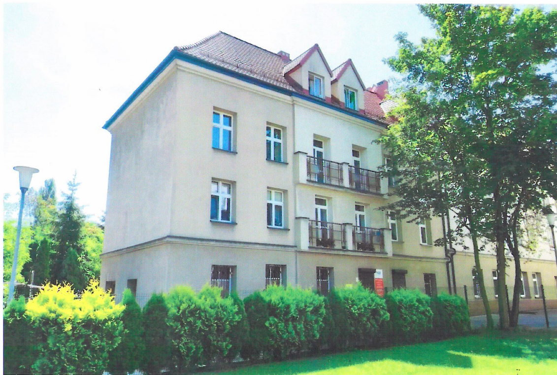
Widok budynku od północnego-zachodu
