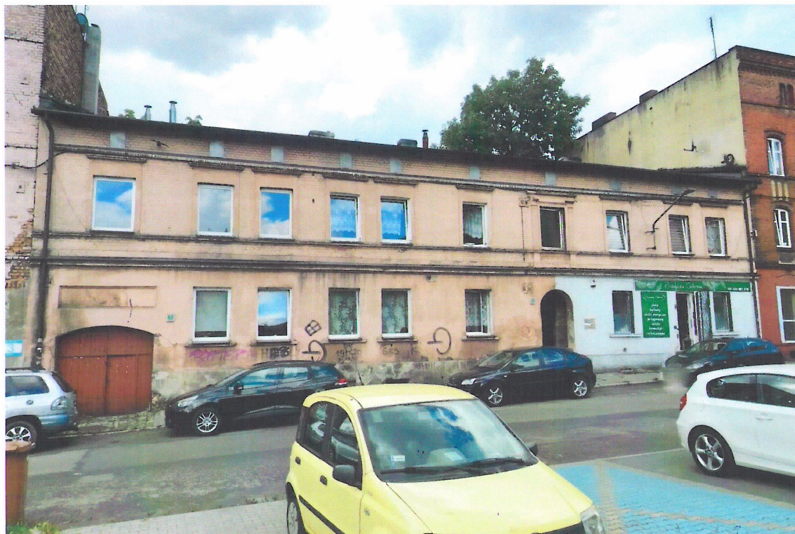
Widok budynku od północnego-wschodu
