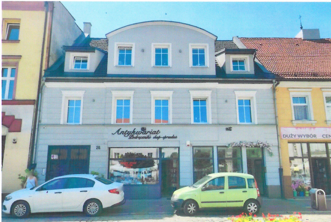
Widok budynku od północnego-wschodu
