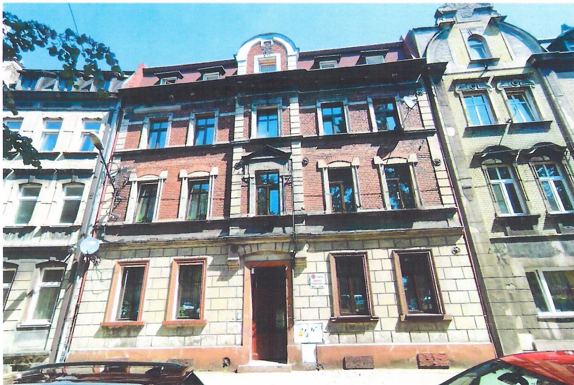
Widok budynku od południowego-zachodu
