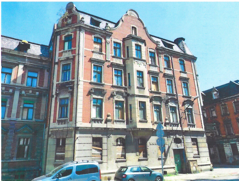
Widok budynku od południowego-zachodu
