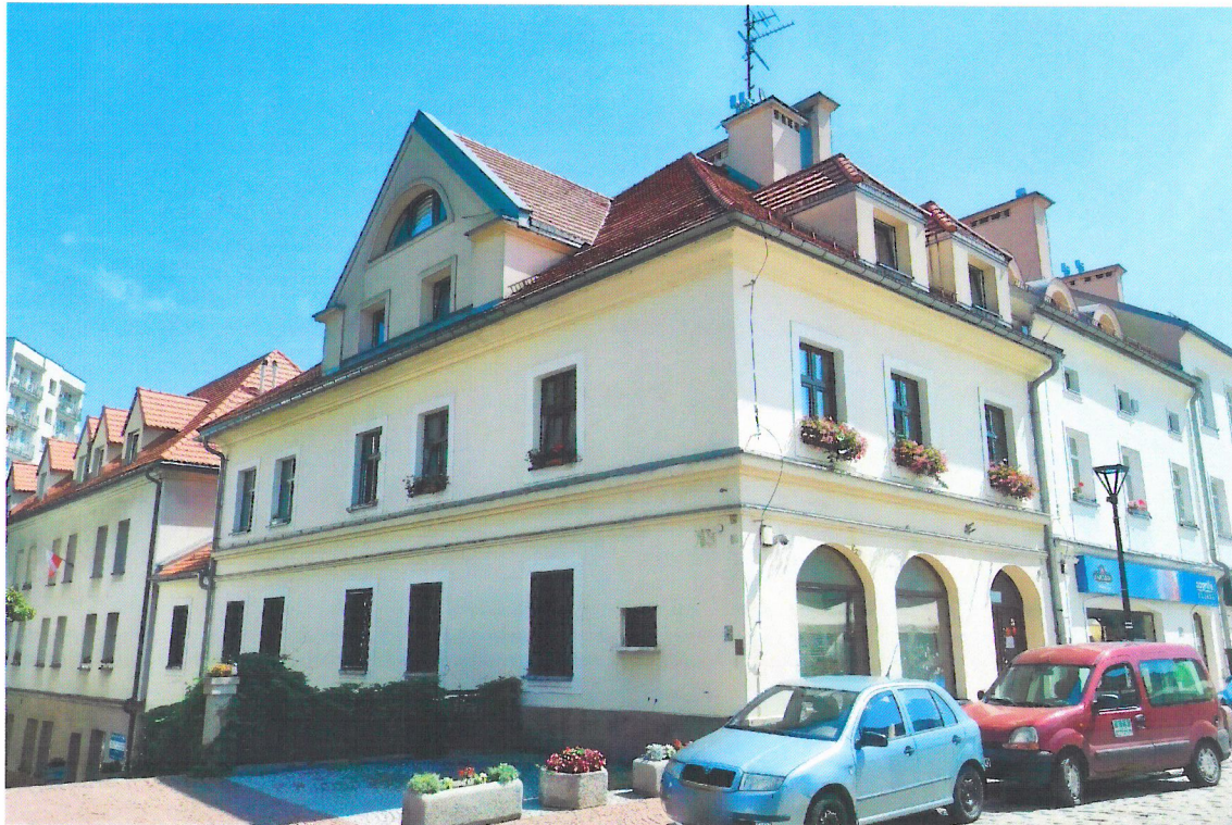
Widok budynku od południowego-zachodu
