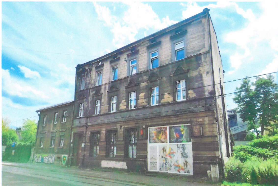
Widok budynku od północnego-wschodu
