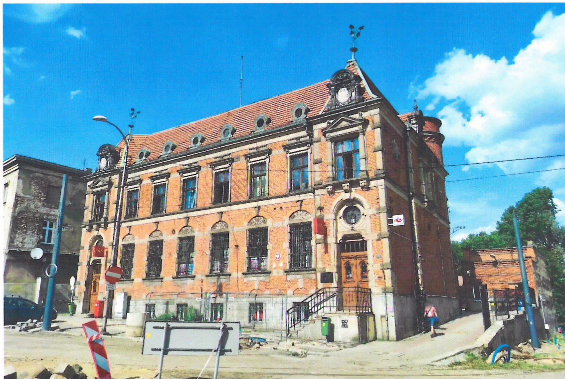
Widok budynku od północno-zachodu
