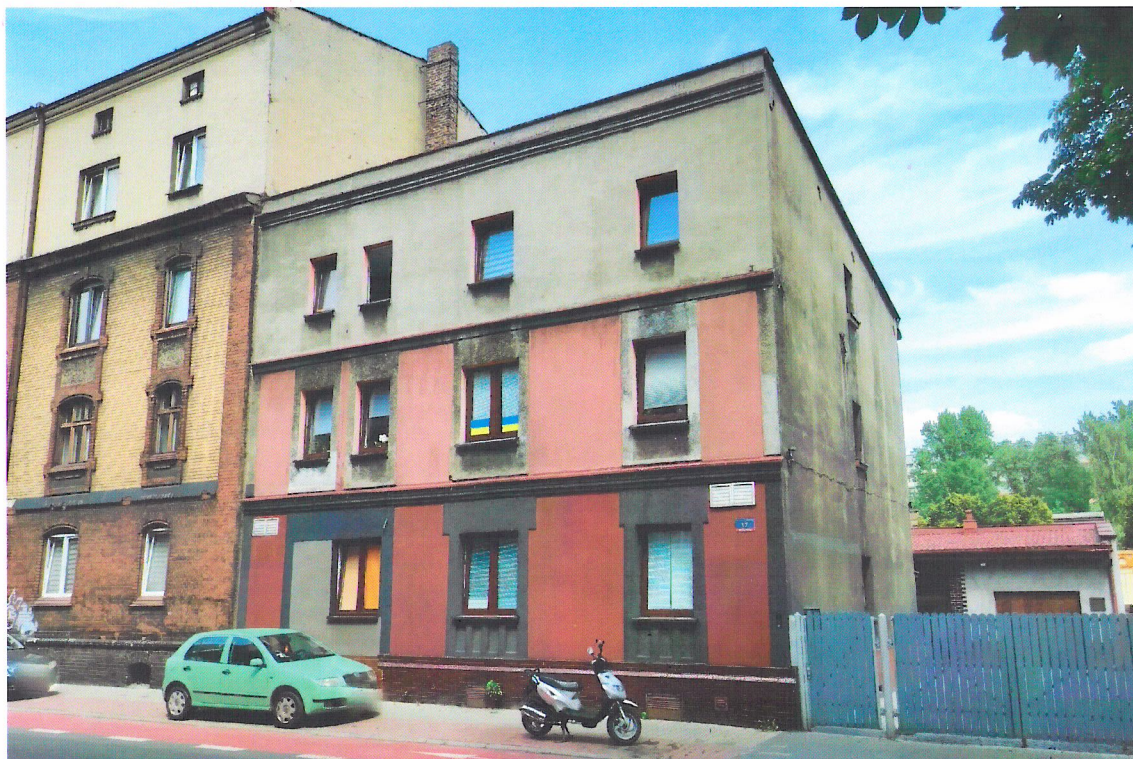
Widok budynku od południa
