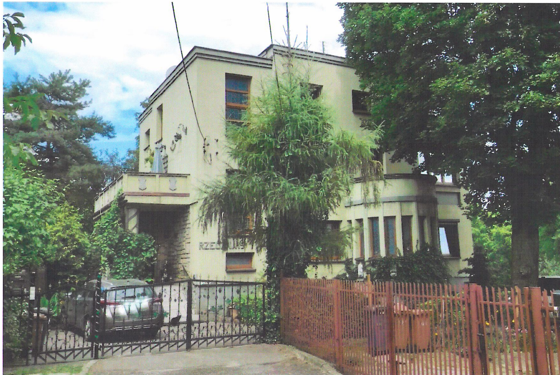
Widok budynku od północnego-wschodu
