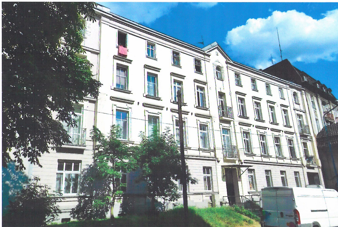
Widok budynku od wschodu
