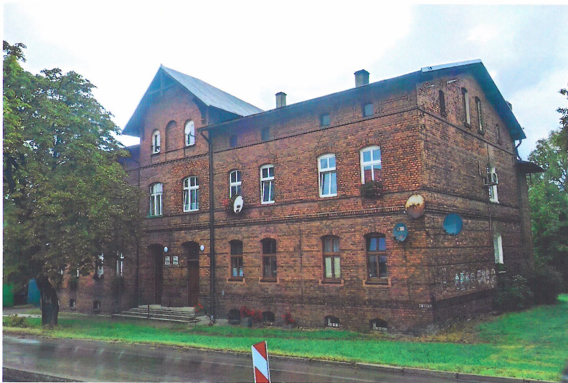
Widok budynku od południowego-wschodu
