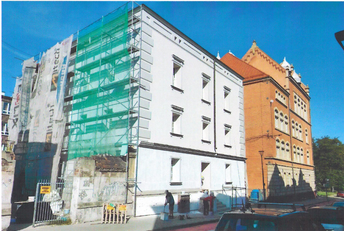
Widok budynku od południowego-wschodu
