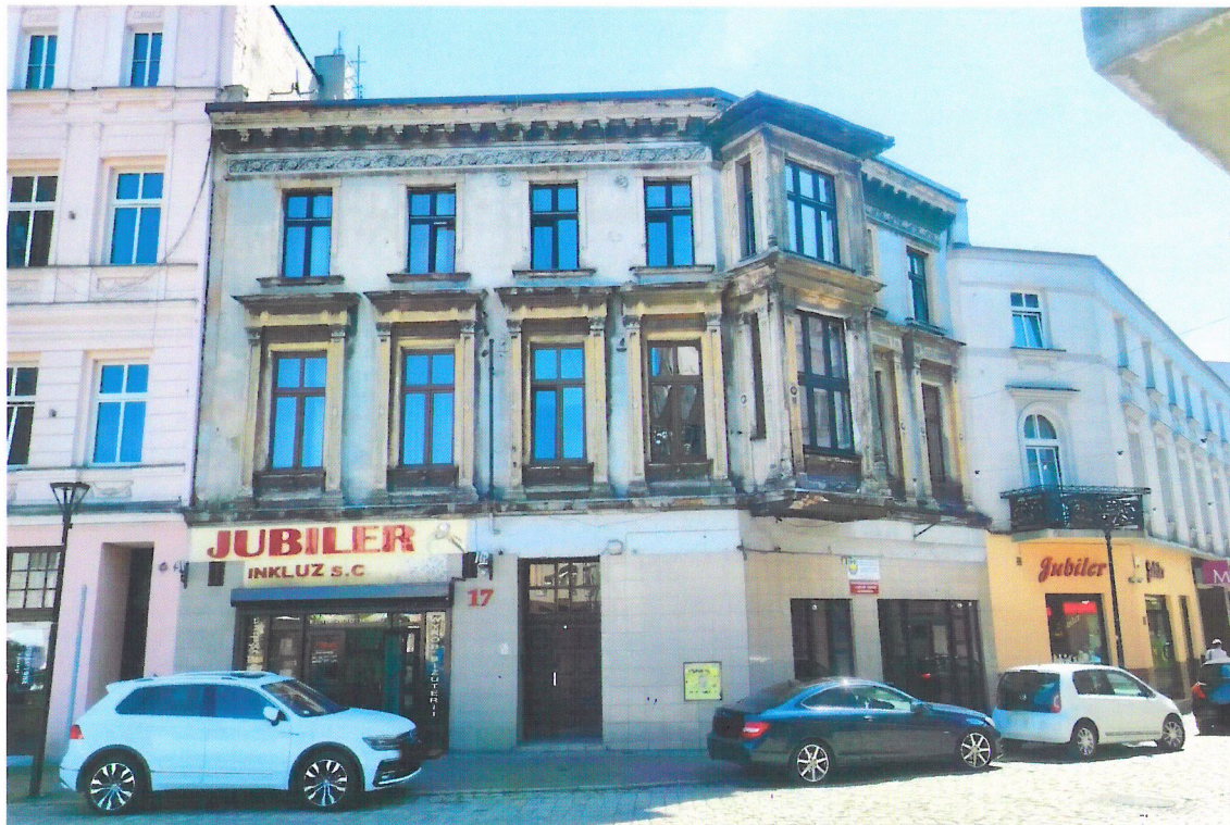
Widok budynku od północnego-zachodu
