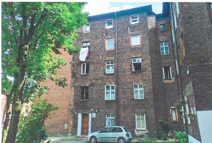
Widok budynku od północnego-zachodu
