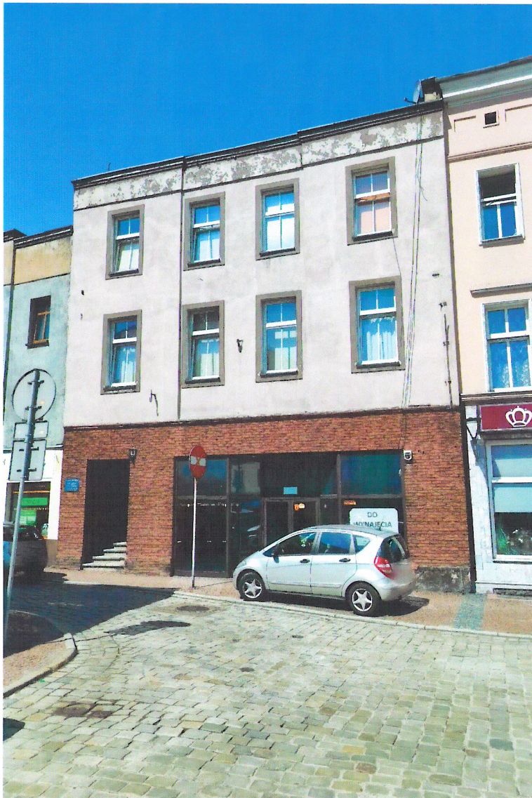
Widok budynku od południowego-wschodu
