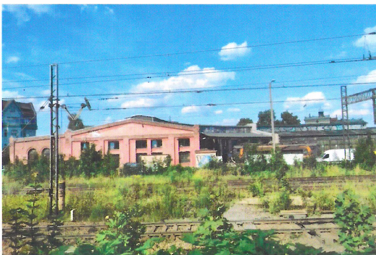
Widok budynku od południowego-zachodu
