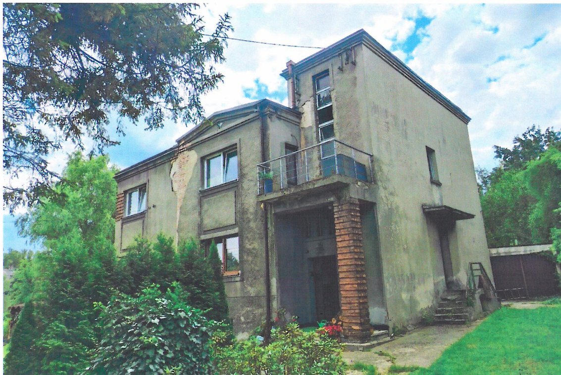
Widok budynku od północnego-wschodu
