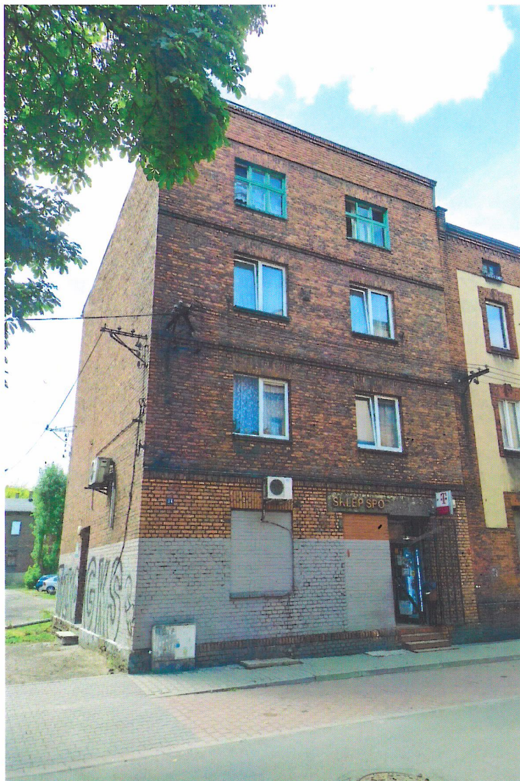
Widok budynku od północnego-wschodu
