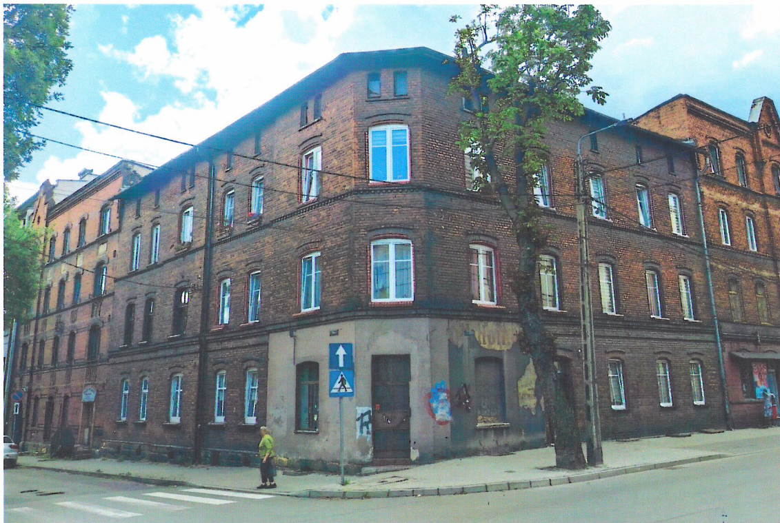
Widok budynku od północnego-wschodu
