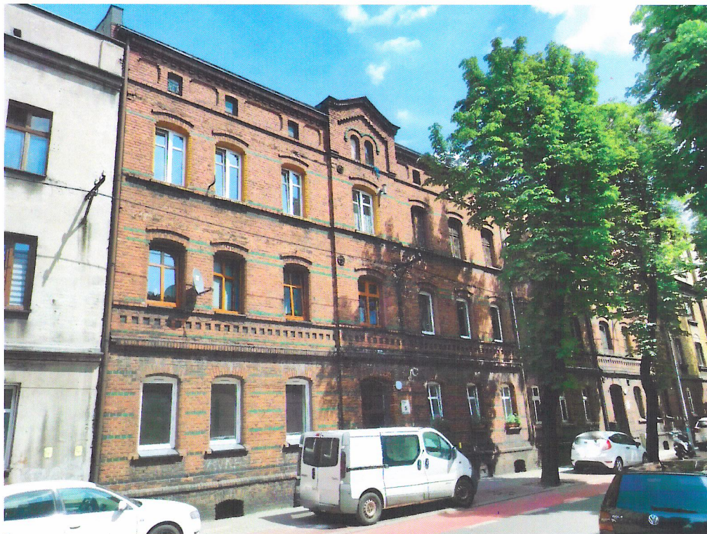
Widok budynku od południowego-zachodu
