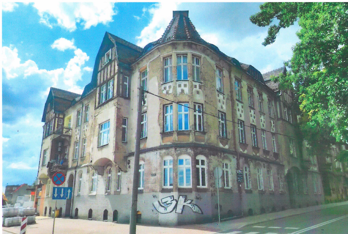
Widok budynku od północnego-wschodu
