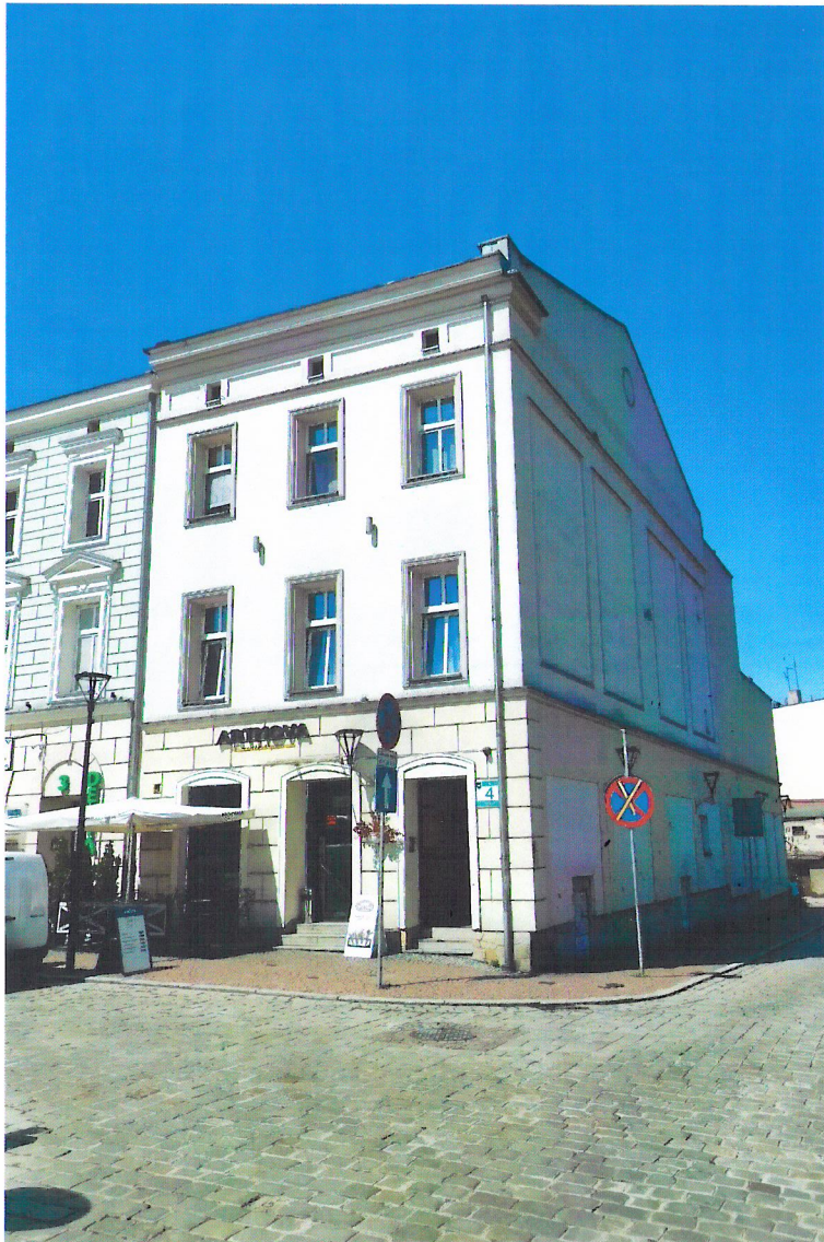
Widok budynku od północnego-wschodu
