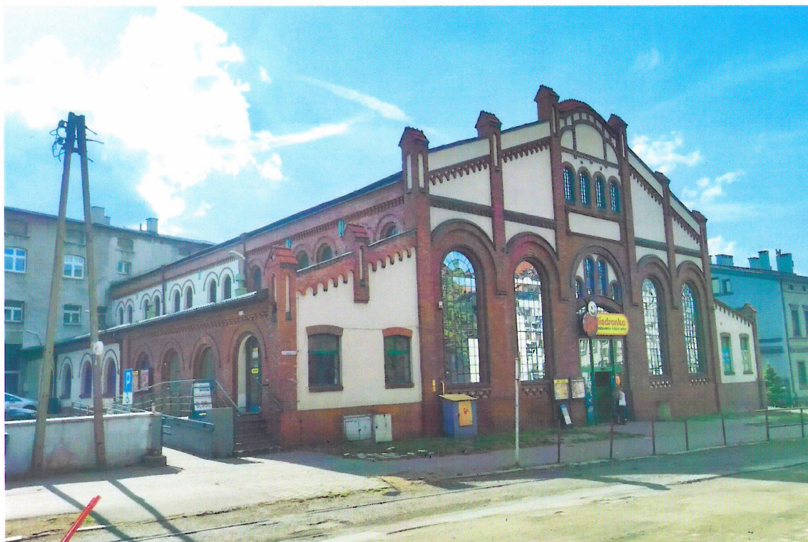
Widok budynku od południowego-wschodu
