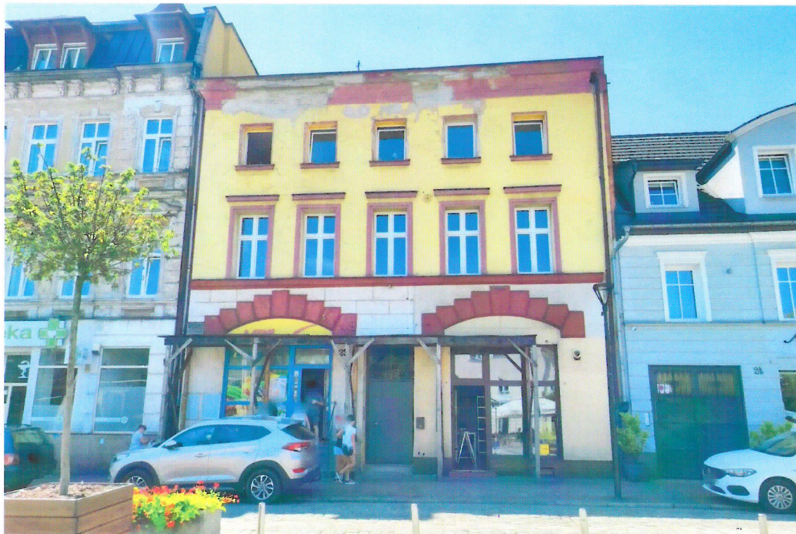
Widok budynku od północnego-wschodu
