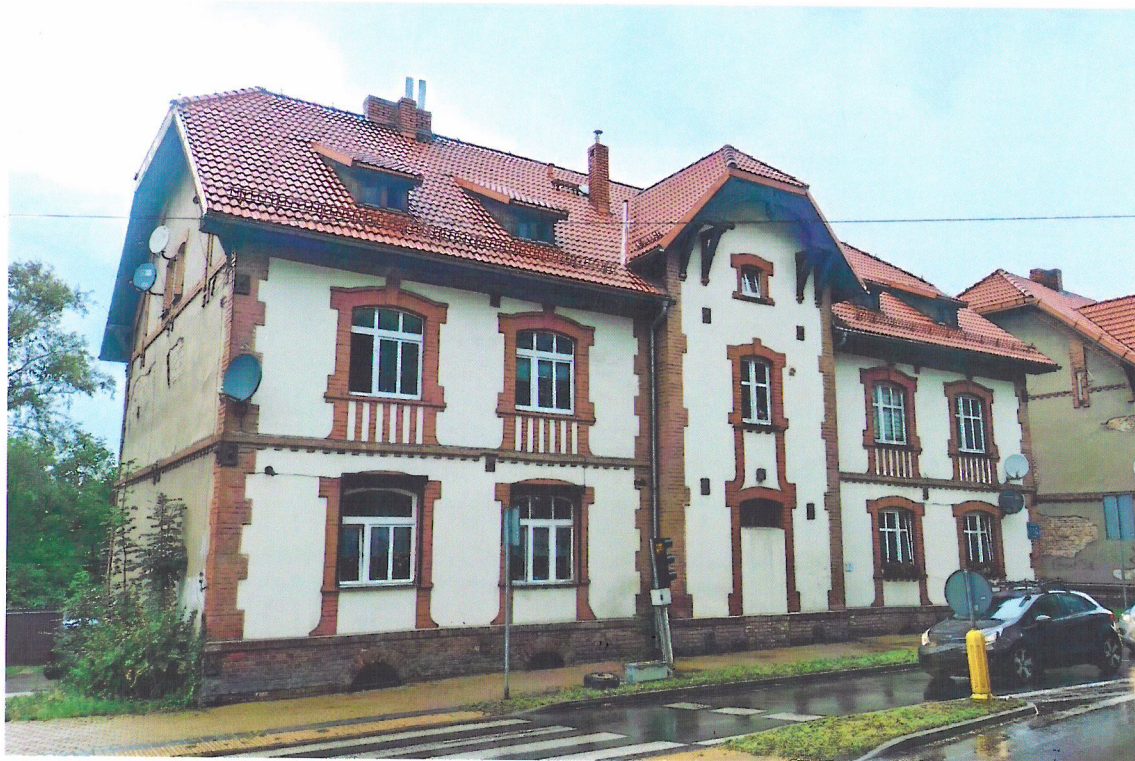
Widok budynku od południa
