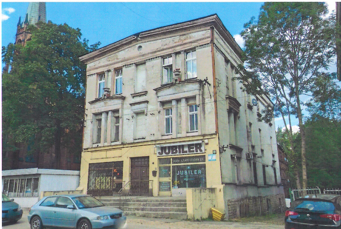
Widok budynku od południowego-zachodu
