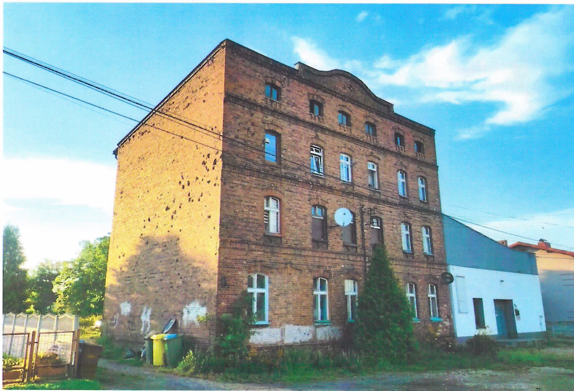
Widok budynku od północnego-wschodu
